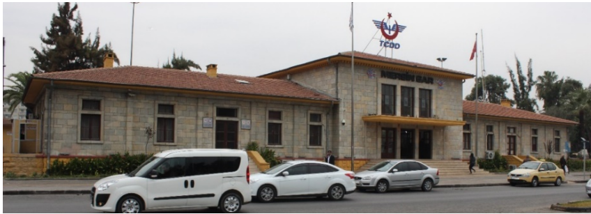
Görsel6. Mersin Tren İstasyon binası Güney Cephesi (Tuğba Levent Kasap, 2015, Ekim)
