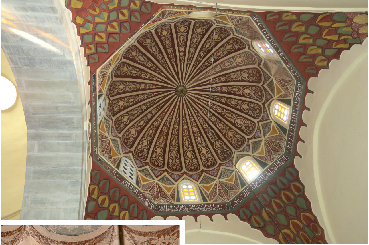
Görsel 13 Eyvan kubbesi 2010 onarım sonrası.
