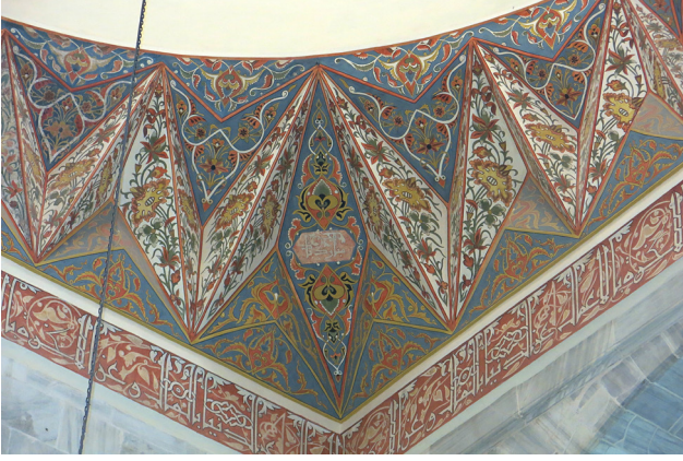
Görsel 11 Giriş holü kubbe kasnağı 2010 onarımı kalemiş- leri.
