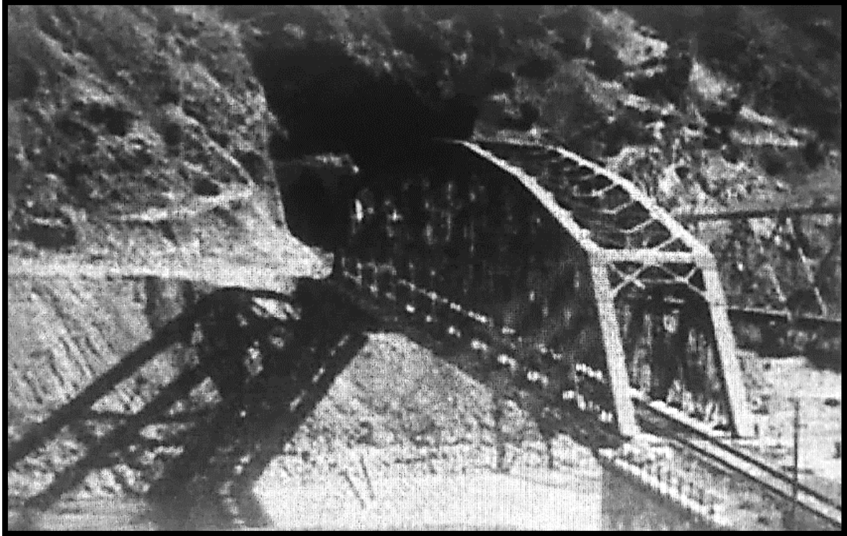
Ek 4: Murat Nehri üzerindeki demir köprü (CCA, Fon Kodu: 030.01.00.00. Yer No: 134.874.2.21)
