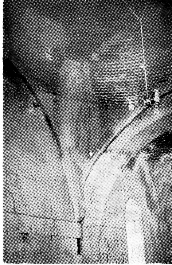
Res. 14— İbrahim Paşa Camisi. Kubbe geçişi.
