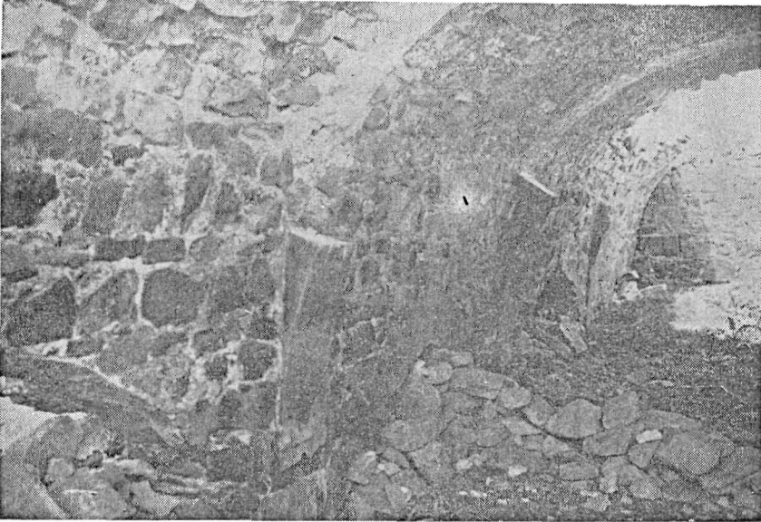
Res. 6— Kamereddin Hanı. Kapalı kısım orta sahnında destek kemerleri.
