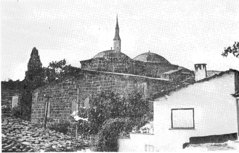
Res. 4— Bergama Ulu Camii, gúney cephe.
