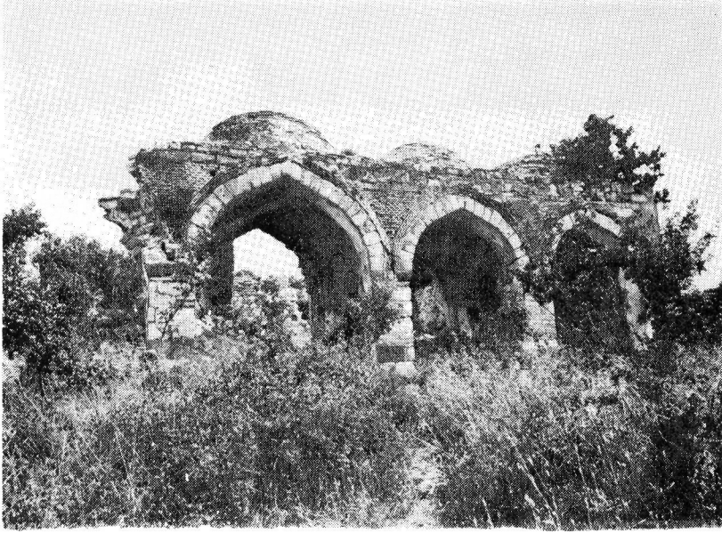
Res. 1— Çeşme Köyü Camisi. Kuzeyden görünüş.
