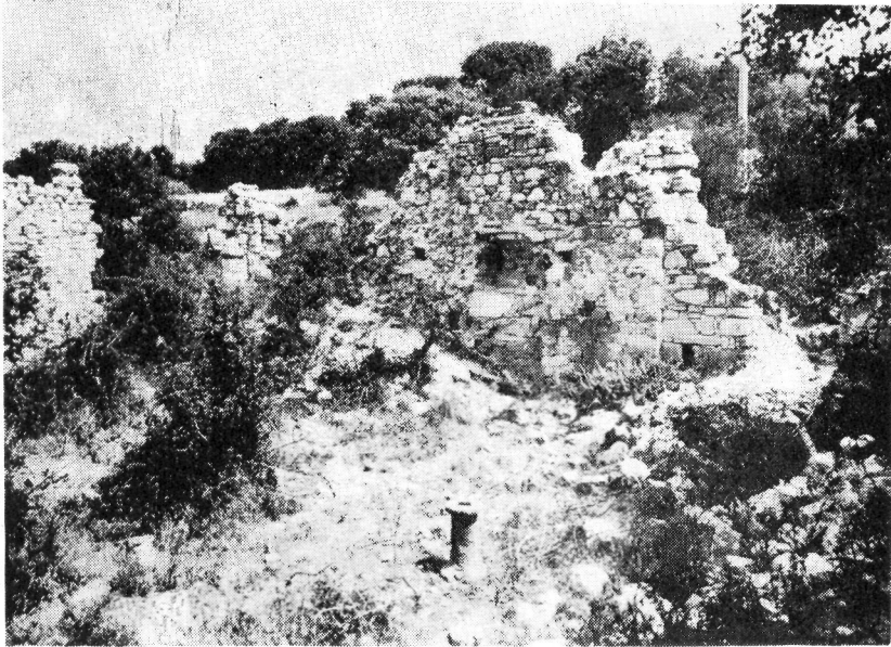
Res. 8— Çeşme Köyü Camisi. Harim kible duvarının içten görünüşü.
