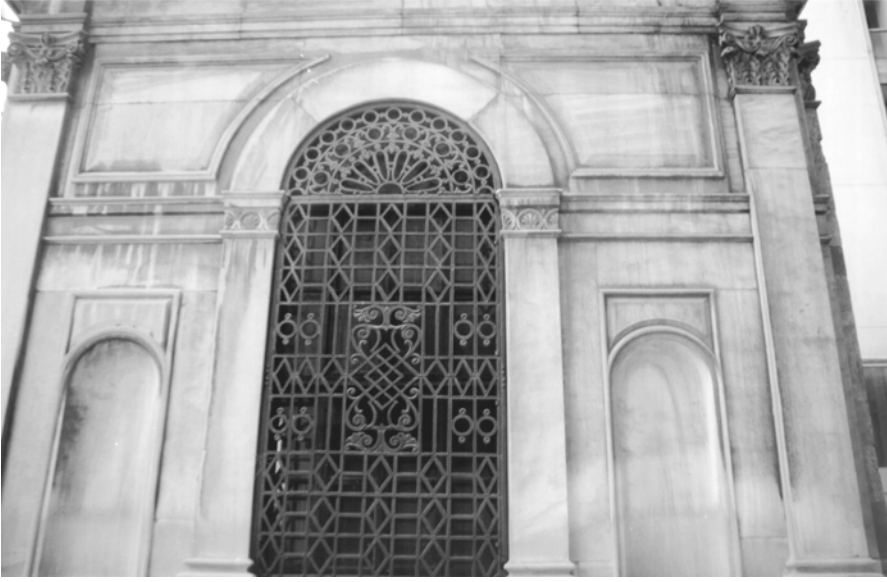
Res. 15- Cağaloğlu Mahmud Nedim Paşa Türbesi, pencere şebekesi.
