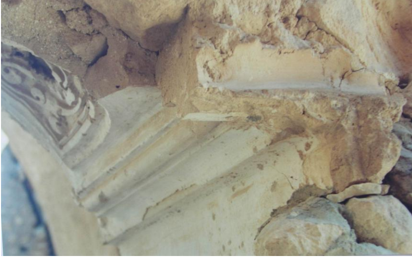
Res.11- Koç Camisi, Eyvandaki Kapı Nişi Açıklığının Arka Yüzünde Görülen Silme Kalıntısı.
