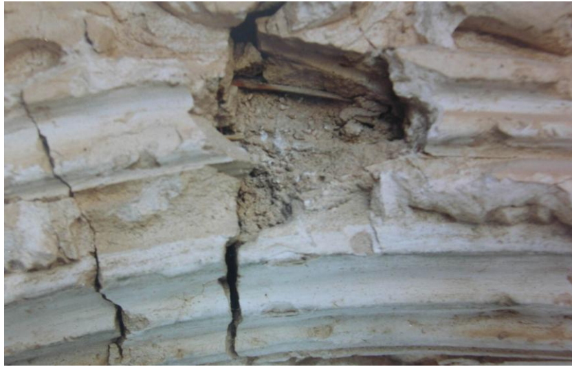
Res.10- Koç Camisi Eyvan Duvarındaki Kavsara Süslemelerinde Alçı Harcı İçinde Kullanılan Kamuş
