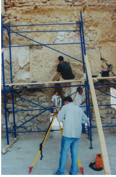
Res.13- Koç Camisi, Eyvan Süslemeleri Üzerinde Yapılan Geçici Koruma Çalışmaları
