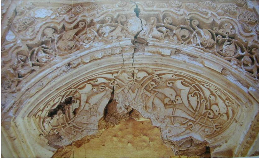
Res. 8- Koç Camisi Eyvan Duvarındaki Kavsara Yarım Kubbesi
