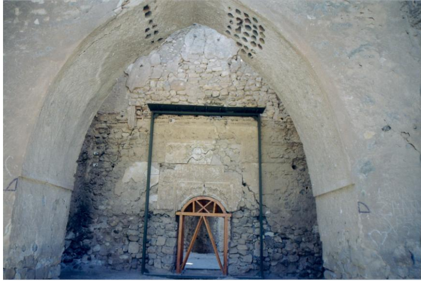
Res.16- Koç Cami Eyvan Duvarında Yapılan Geçici Destek (Foto M. Çeken)
