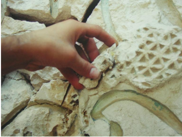
Res.14- Koç Camisi, Eyvan Süslemelerindeki Geçici Koruma Çalışmalarından Bir Detay
