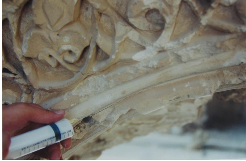
Res.15- Koç Camisi, Eyvan Süslemelerindeki Geçici Koruma Çalışmalarından Bir Detay.
