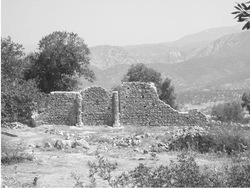
Res. 34-Seymenlik Zaviyesi. Toplantı salonu batı duvarının dıştan görünüşü. (Konservasyon sonrası).
