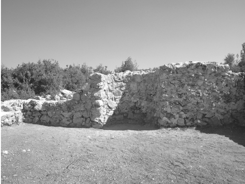
Res. 30- Mentese Mezarlığı. Mihrap duvarının içten görünüşü. (Konservasyon sonrası).
