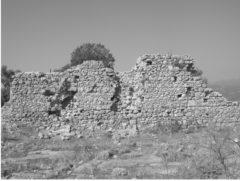
Res.33- Seymenlik Zaviyesi. Toplantı salonu batı duvarının dıştan görünüşü. (Konservasyon öncesi).
