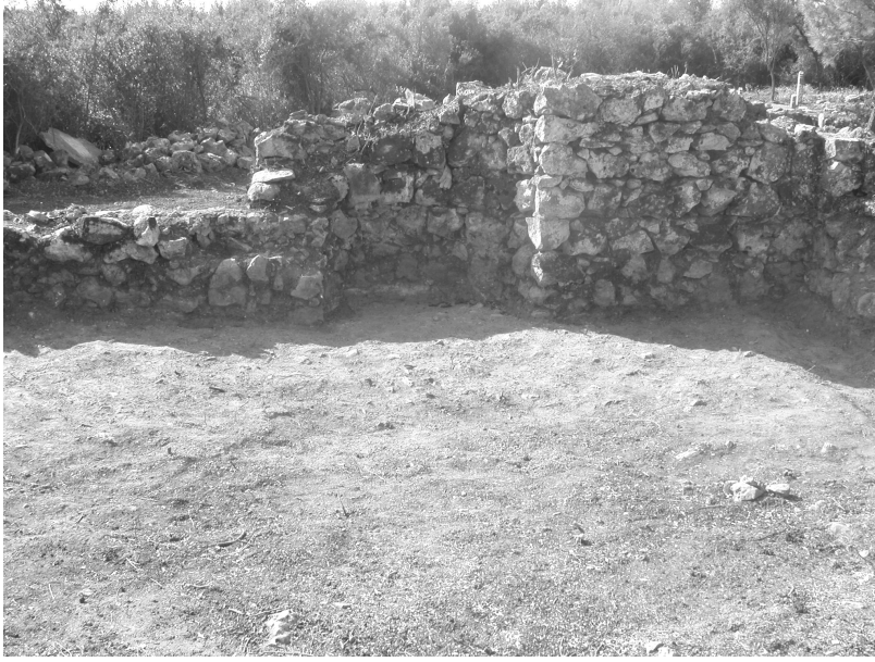
Res.29- Mentese Mezarlığı. Mihrap duvarının içten görünüşü. (Konservasyon öncesi).
