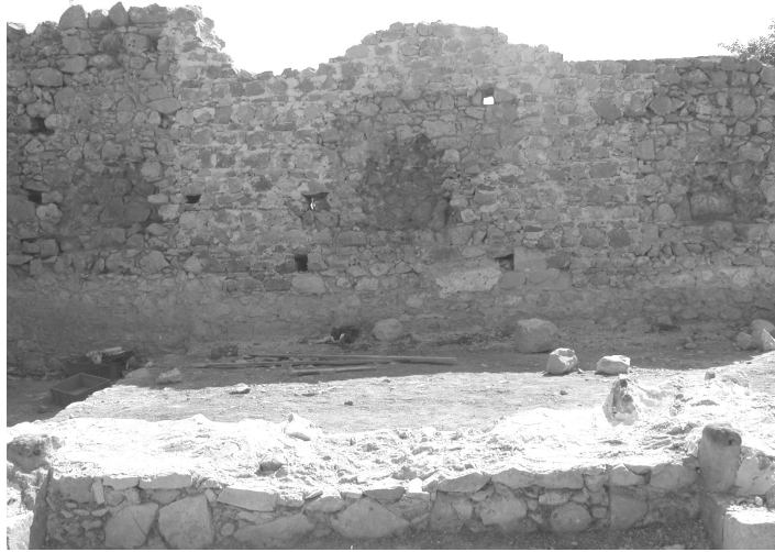
Res. 32-Seymenlik Zaviyesi. Toplantı salonu batı duvarının içten görünüşü. (Konservasyon sonrası).
