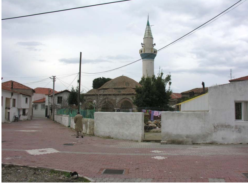
Fot. 7- Sığacık Camii, kuzey cephesi.
