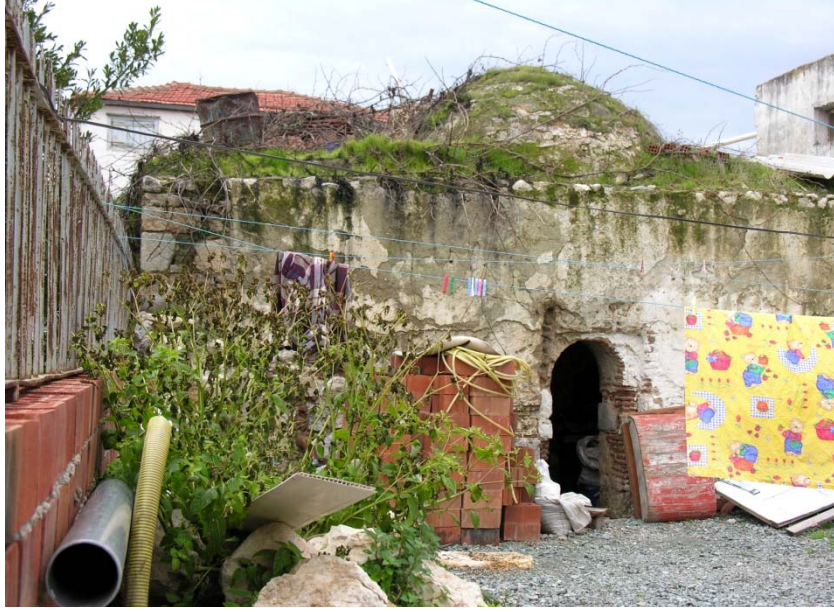
Fot. 11- Sığacık Hamamı, kuzey cephesi.
