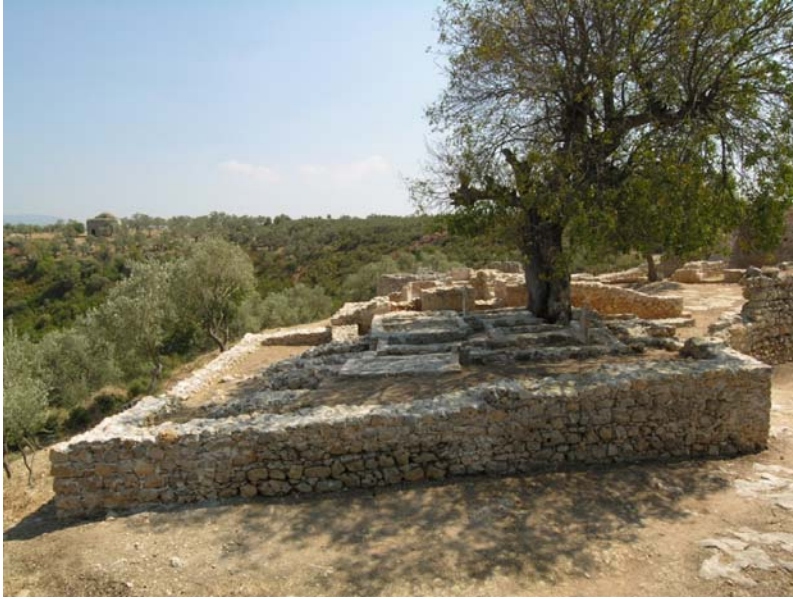
Res.34- Seymenlik Zaviyesi Haziresi. Onarılan çevre duvarları.
