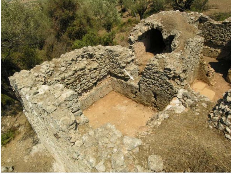
Res.23- Yelli Hamam. Sıcaklık mekanının kuzeybatı köşesindeki halvet hücresinde su deposuna açılan kontrol penceresi.
