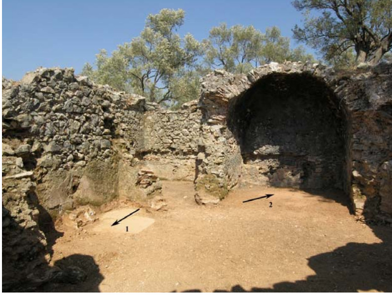
Res.21- Yelli Hamam. Sıcaklık mekanında kuzey ve doğu eyvanları.
