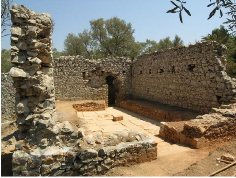
Res.15- Yelli Hamam. Soyunmalık mekanının kuzeybatıdan görünüşü
