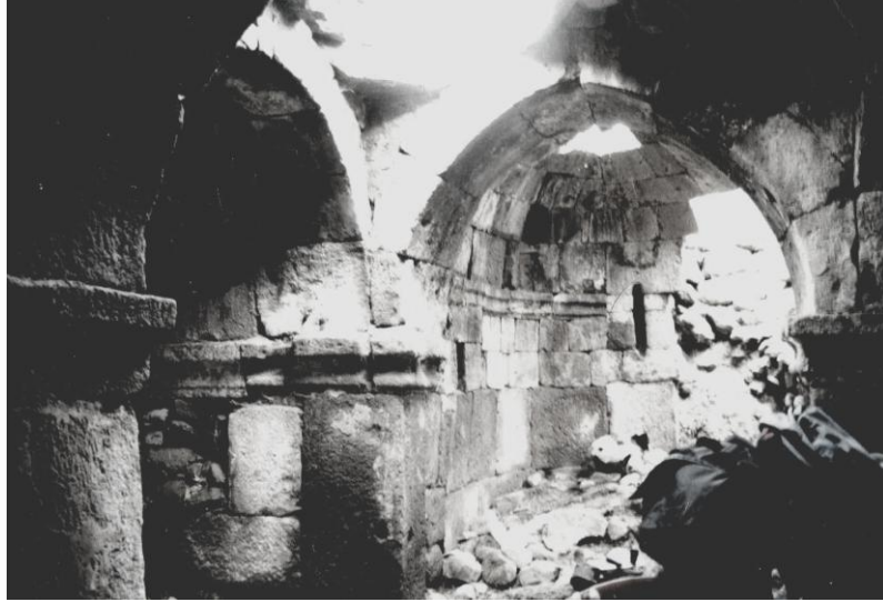
Resim 3- Niğde, Kitreli, Kilise, Naos, Naos, Kuzeydoğuya Bakış.
