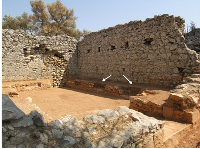
Res.7- Yelli Hamam. Soyunmalık mekanının güneydoğu köşesi. Sekiler ve üzerlerindeki girintiler (okla işaretli).
