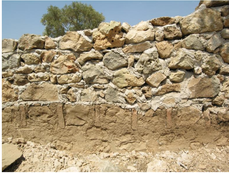
Res.4- Emir Avlusu. Küçük avlunun güney duvarı üzerinde tuğla kasetlemeli bölüm
