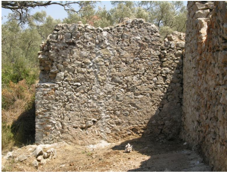
Res.35- Yelli Hamam. G hücresinin kuzeybatı köşesi (onarım sonrası)
