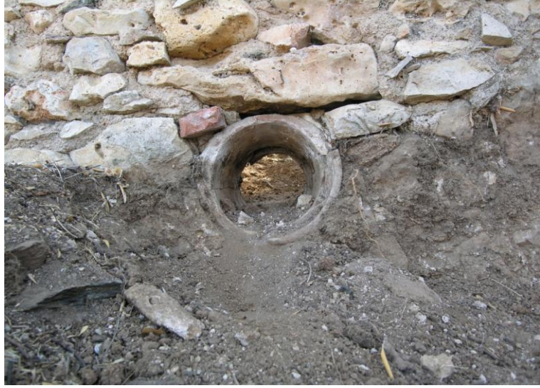
Res.5- Emir Avlusu. Küçük avlunun güney duvarı üzerindeki pişmiş toprak küngün avlu içinden görünüşü.
