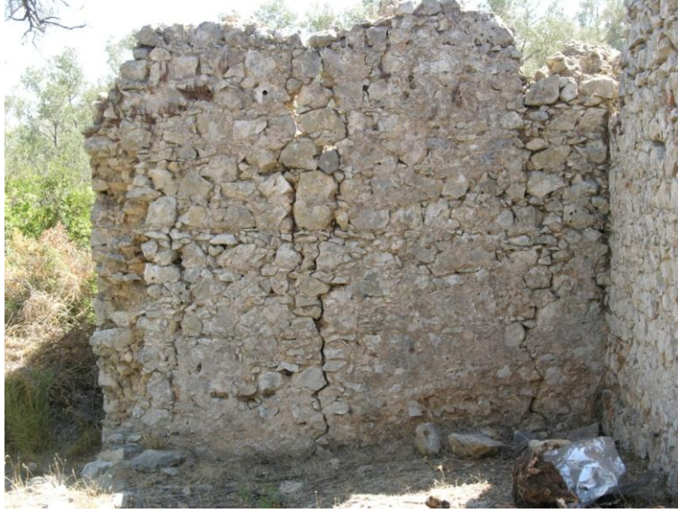
Res.34- Yelli Hamam. G hücresinin kuzeybatı köşesi (onarım öncesi)
