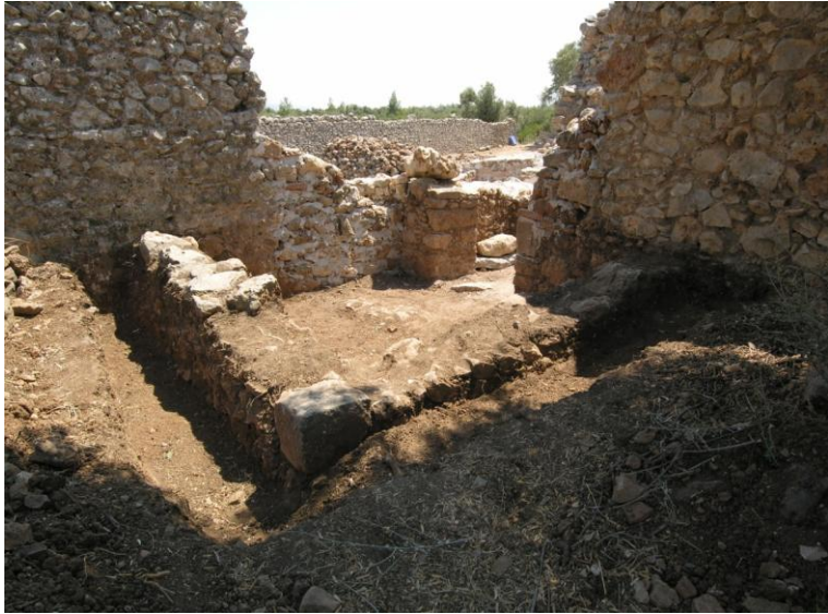
Res.6- Emir Avlusu. Büyük avlunun kuzeydoğusuna eklenen muhdes mekan
