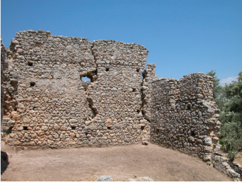
Res.6- Lokman Zaviyesi. II ve III No.lu mekanları ayıran duvarın batı cephesi. (III No.lu mekanı örten ana kirişin deliği okla işaretli).
