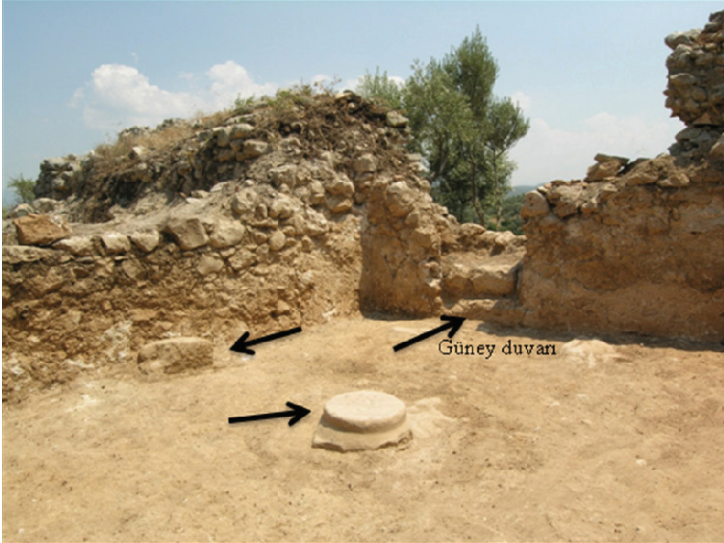
Res.15- Seymenlik Kapısı. B mekanının güney duvarı üzerindeki açıklık ve destek kaideleri
