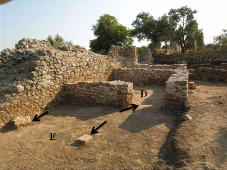
Res.19- Seymenlik Kapısı. E mekanı içindeki destek kaideleri ve D mekanı ile E mekanı arasındaki açıklık.
