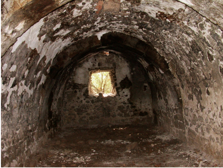
Res.14- Büyük Yenice Hanı. Batı ahırının güney kesimi. Phot.14- Le Grand Khan de Yenice. La partie sud de l'écurie de l'ouest.
