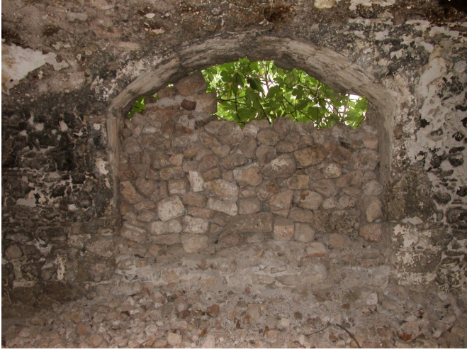
Res.13- Büyük Yenice Hanı. Kuzey ahırında sonradan açılmış olan kapının içten görünüşü. Phot.13- Le Grand Khan de Yenice. La baie d'entrée creusée après coup dans le mur nord. Vue prise de l'intérieur
