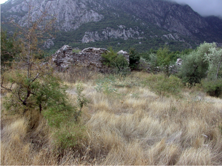
Res.1- Küçük Yenice Hanı kuzey cephesi Phot.1- Le Petit Khan de Yenice. Façade nord.
