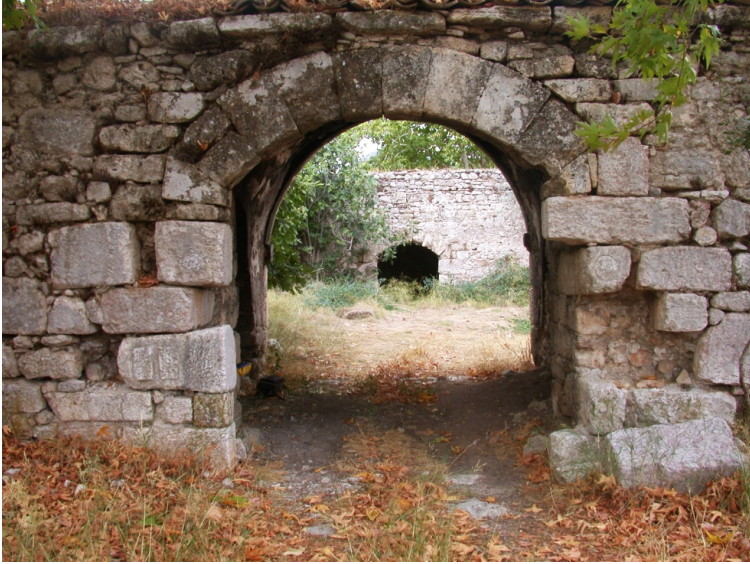
Res.8- Büyük Yenice Hanı. Kuzey cephesi üzerindeki giriş açıklığı.
