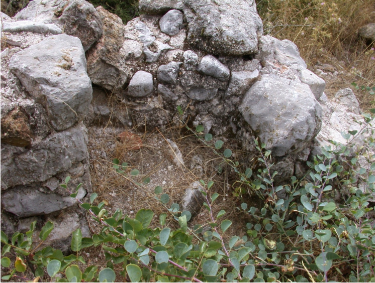
Res.4- Küçük Yenice Hanı. Güney duvarı üzerindeki niş Phot.4- Le Petit Khan de Yenice. Niche creusée dans le mur sud.
