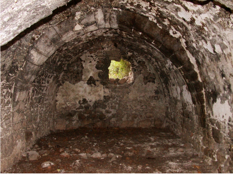
Res.9- Büyük Yenice Hanı. Giriş eyvanının güneyindeki mekan.
