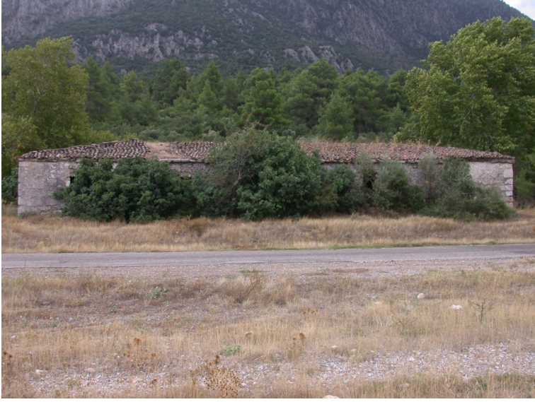
Res.5- Büyük Yenice Hanı kuzey cephesi
