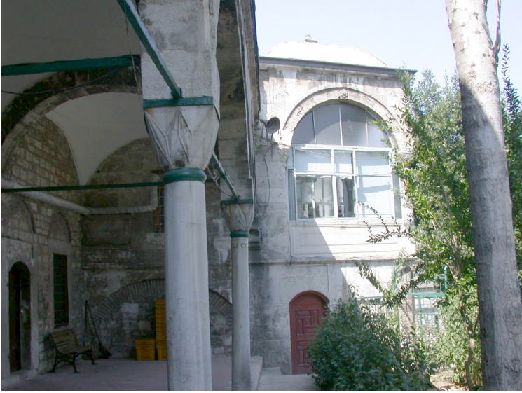
Res.4- Ahmediye Kütüphanesi, medrese odalarına bitişik olan güney cephesi.
