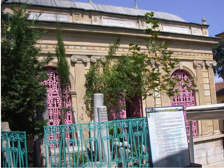
Res.26- Aziz Mahmut Hüdai Külliyesi (Lütfi Bey) Kütüphanesi, güney cephesi.
