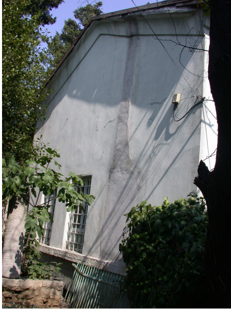
Res.24- Pertev Paşa Kütüphanesi, batı cephesi.
