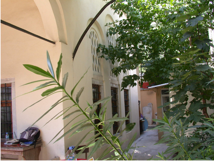
Res.16- Hacı Selim Ağa Kütüphanesi, güney cephesi.
