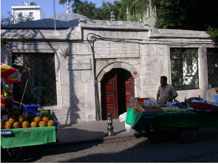
Res.15- Hacı Selim Ağa Kütüphanesi, avlu giriş cephesi.
