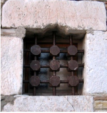
Resim 6: Kaş kemer formu verilmiş söve.
