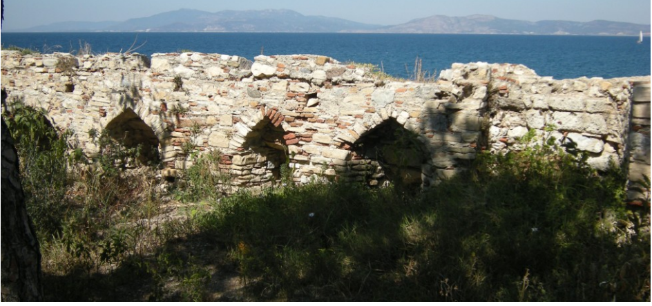
Resim 17: Dış surda bazı kesimler dayaklı tiptedir. Dayaklar birbirine gemi teknesi sivri kemerlerle bağlanmıştır.
