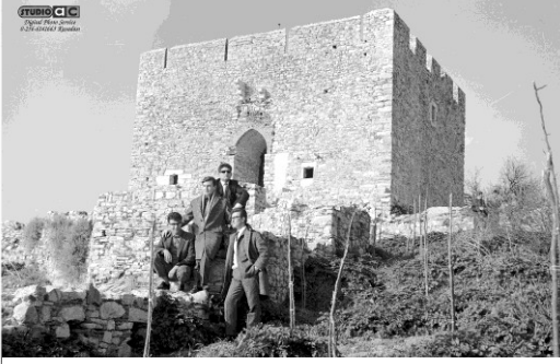
Resim 4: Kuleye giriş sağlayan kapı, güney cephe (Studio AC Arşivi'nden).
