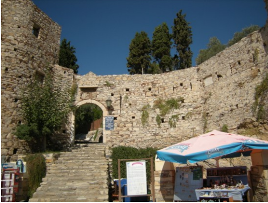
Resim 11: Dış sur, ana giriş kapısı, son restorasyondan önceki durumu.
