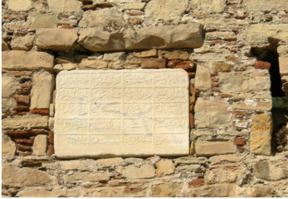
Resim 12: Kitabe levhasının buraya sonradan taşındığı düşünülmektedir. Duvar dokusu da bu öneriyi destekler niteliktedir.
