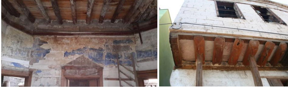
Şekil 15. (solda) içerden döşeme-tavan yapım sistemi elemanları, (sağda) daire kesitli tomrukların, döşeme-tavan detaylarının cepheden dışarı taşan elemanları (Sümeyye Kara, 2016)
