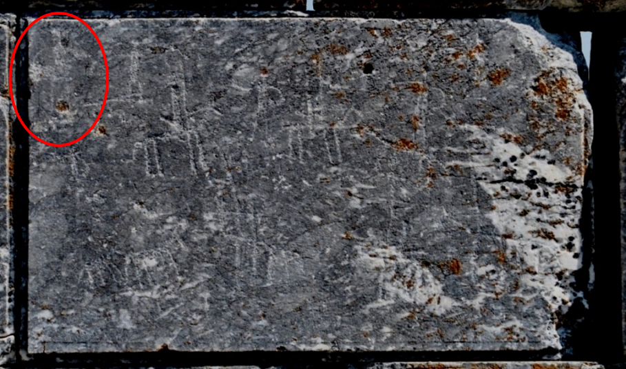
Fot. 13: Kuzey İç Cephe, Alttan Altıncı Sırada, Doğudan Batıya Doğru İkinci Blok
