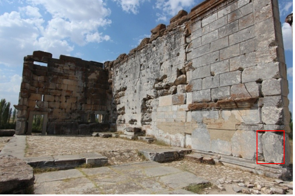
Fot. 9: Aizanoi Zeus Tapınağı'nın Güneydoğudan Görünümü (İç Cephe)
