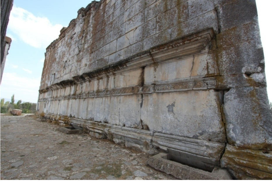
Fot. 2: Aizanoi Zeus Tapınağı Kuzey Duvarı Kuzey Cephesi (Dış Cephe)
