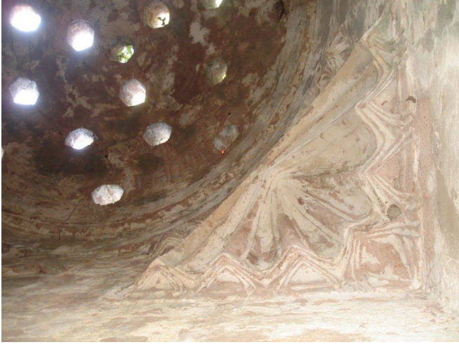
Fotoğraf 15. Urla Kamanlı Hamamı. Halvet Örtüsündeki Geçişlerden Detay.
