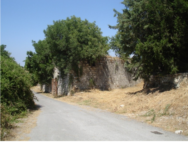
Fotoğraf 1. Urla Kamanlı Hamamı. Güneybatıdan Genel Görünüş.
