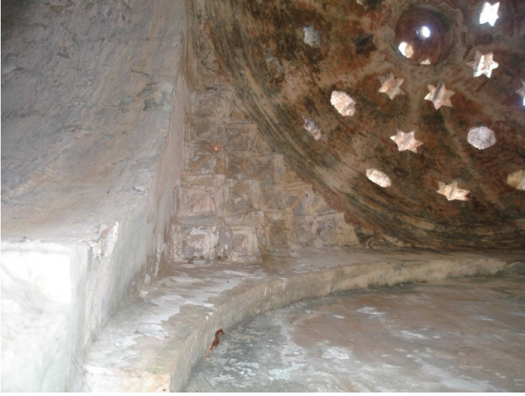
Fotoğraf 11. Urla Kamanlı Hamamı. Sıcaklık Mekanının Örtüsünden Detay.
