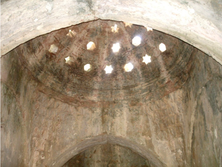
Fotoğraf 10. Urla Kamanlı Hamamı. Sıcaklık Mekanının Örtüsü.
