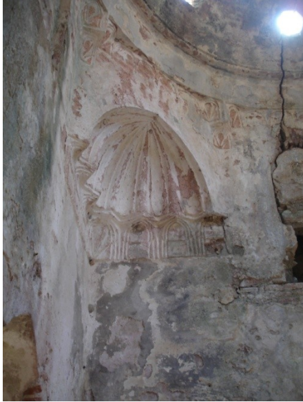
Fotoğraf 14. Urla Kamanlı Hamamı. Halvet Örtüsündeki Geçişlerden Detay.
