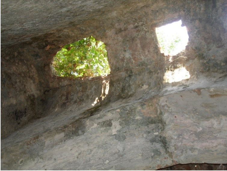
Fotoğraf 8. Urala Kamanlı Hamamı. Sıcaklık Mekanı. Deforme Olmuş Işıklıklardan Detay.
