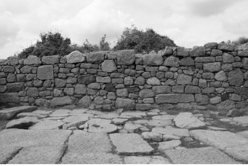
Resim 5: Assos'da kırık çatı kiremitleri ve tuğla parçalarının derz dolgusu olarak kullanıldığı düzensiz örgü tekniğinde inşa edilmiş olan Geç Antik duvarlar
