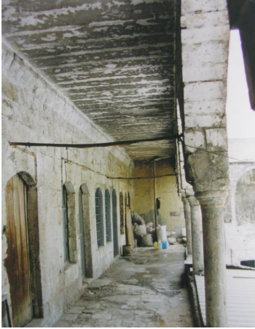
Res.13- Barutçu Hanı, üst kat doğu revakı
