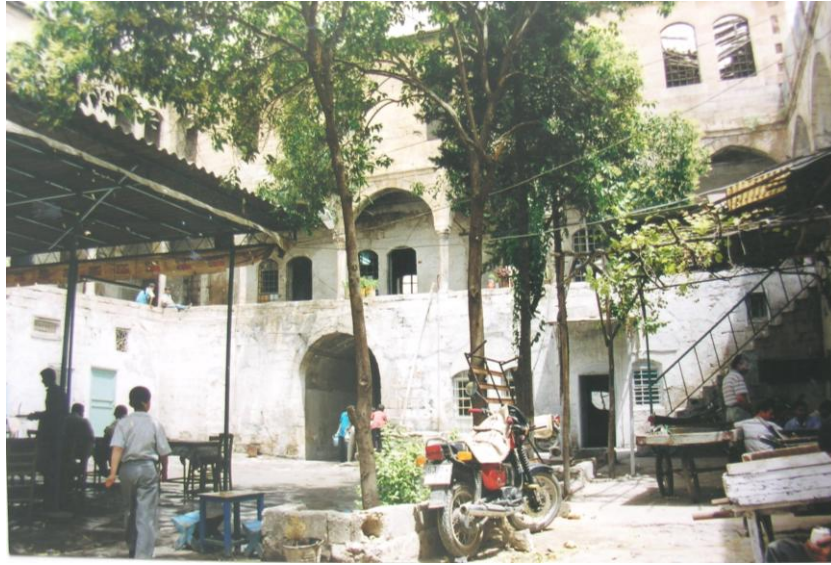
Res.8- Barutçu Hanı, avlu kuzey kanat
