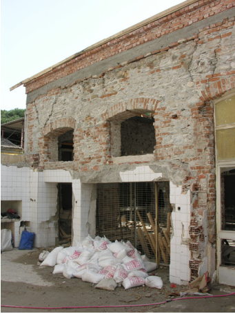
Fotoğraf 23- Himaye-i Etfal Kahvehanesi, kuzey cephede raspa çalışmalarında tespit edilen pencereler.
