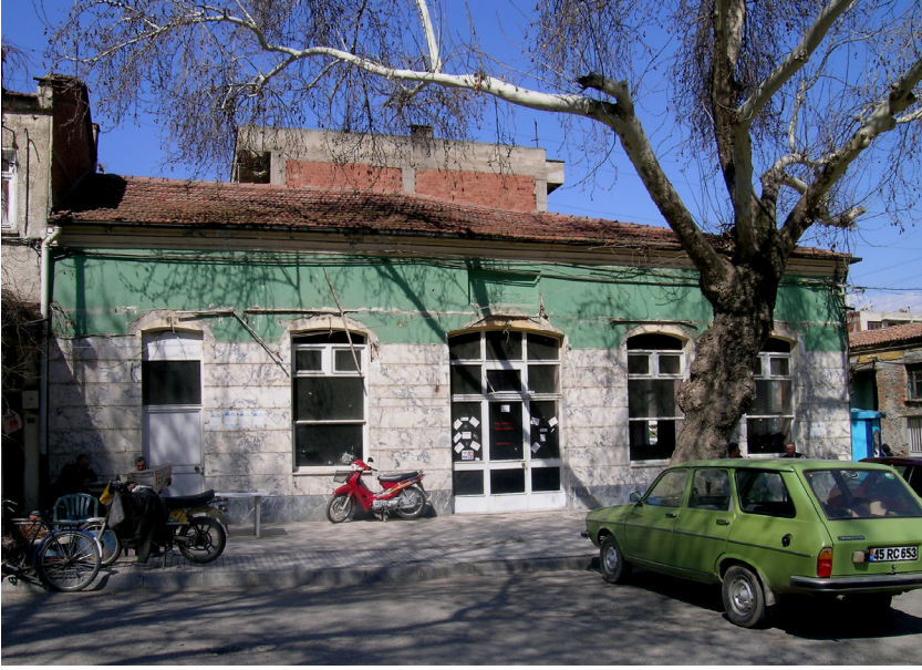
Fotoğraf 9- Himaye-i Etfal Kahvehanesi, güney cephe. Onarım öncesi.
