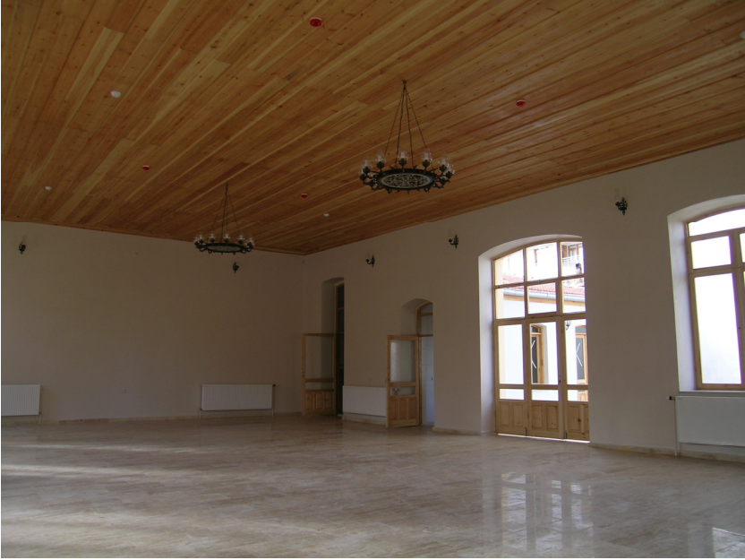
Fotoğraf 26- Himaye-i Etfal Kahvehanesi, kuzey cephedeki kapı açıklıkları. Onarım sonrası.
