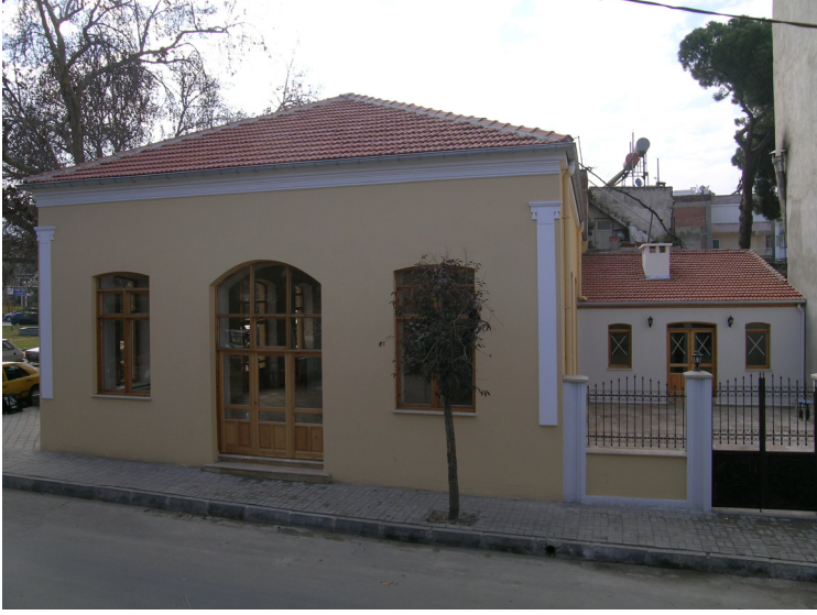
Fotoğraf 22- Himaye-i Etfal Kahvehanesi, doğu cephe. Onarım sonrası.
