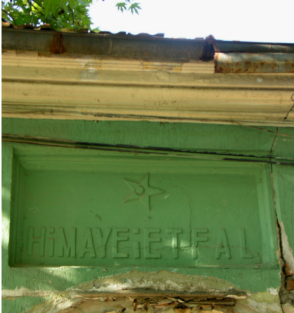
Fotoğraf 10- Himaye-i Etfal Kahvehanesi, güney cephede bulunan yazı panosu. Onarım öncesi.
