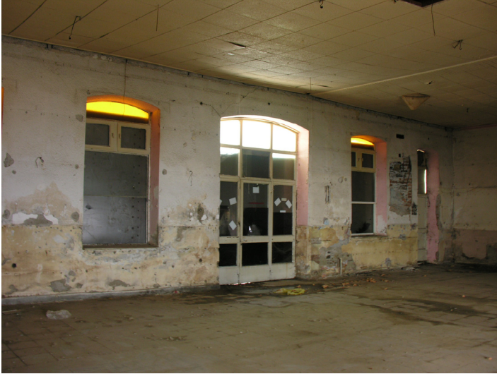
Fotoğraf 17- Himaye-i Etfal Kahvehanesi, yapının içinden bir görünüş. Onarım öncesi.
