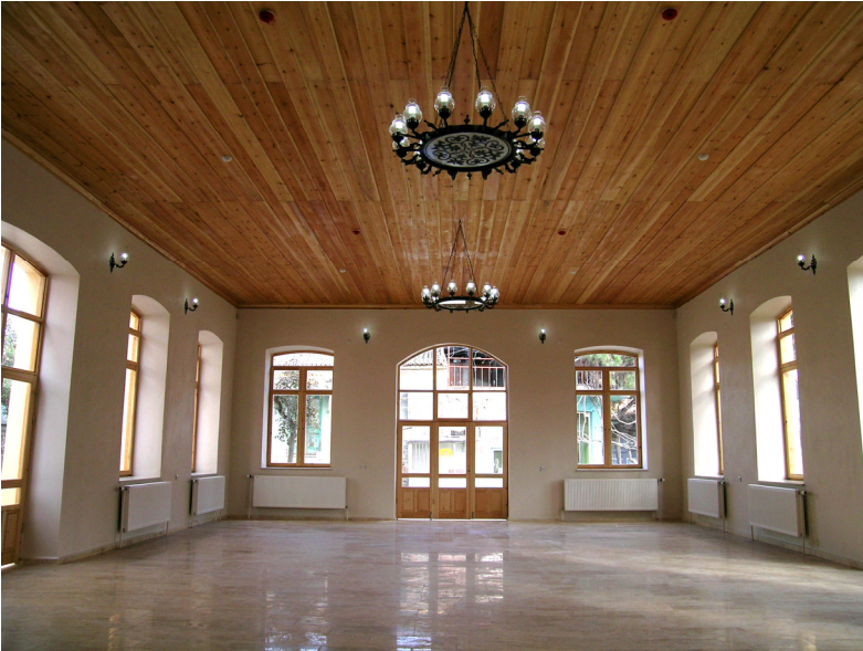
Fotoğraf 28- Himaye-i Etfal Kahvehanesi, iç mekan. Onarım sonrası.
