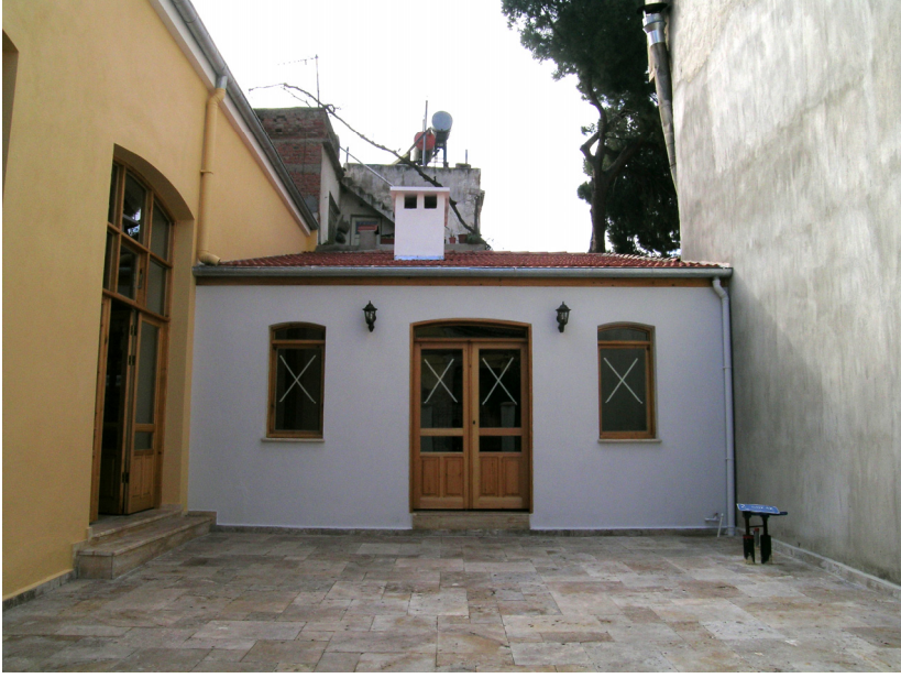
Fotoğraf 27- Himaye-i Etfal Kahvehanesi, kuzey cepheye inşa edilen müştemilat. Onarım sonrası.
