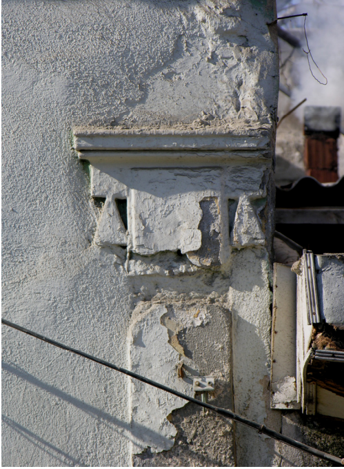
Fotoğraf 13- Himaye-i Etfal Kahvehanesi, doğu cephe. Korunarak bugüne gelebilmiş sütunçe. Onarım öncesi.
