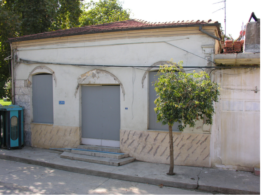
Fotoğraf 12- Himaye-i Etfal Kahvehanesi, doğu cephe. Onarım öncesi.
