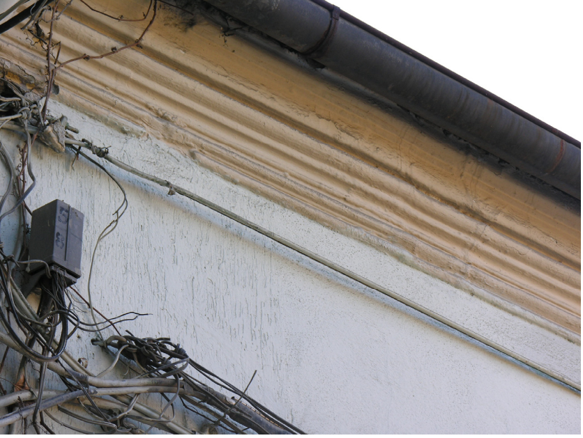
Fotoğraf 11- Himaye-i Etfal Kahvehanesi, güney cephe saçak silmesi. Onarım öncesi.
