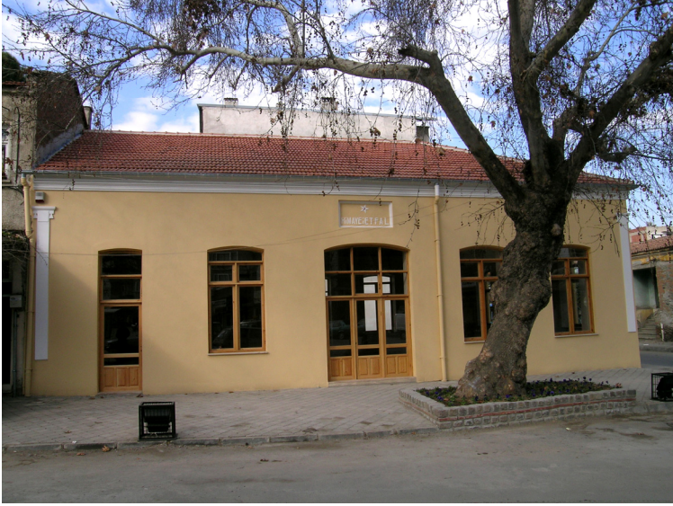
Fotoğraf 18- Himaye-i Etfal Kahvehanesi, güney cephe. Onarım sonrası.
