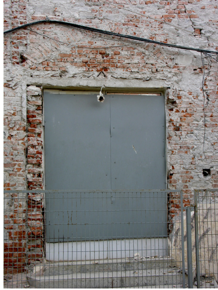
Fotoğraf 21- Himaye-i Etfal Kahvehanesi, doğu cephede yapılan raspa çalışmaları sırasında ortaya çıkarılan orijinal giriş açıklığı.
