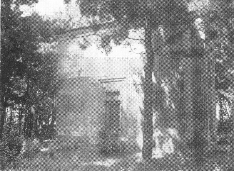
Res. 5- Akşehir-Mâruf (Alanyurt) Köyü Şeyh Hasan Türbesi. Güney cephesi.
