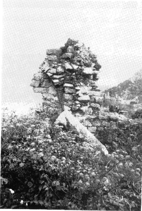
Res. 14- Kilise, narteks, kuzeydoğu köşe.
