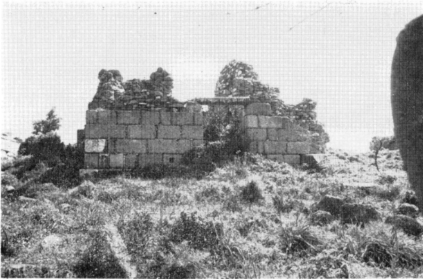
Res. 4- Kilise, batı cephe.
