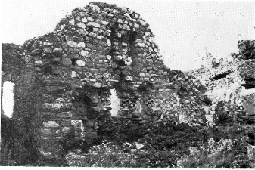
Res. 11- Kilise, içten güney duvar.
