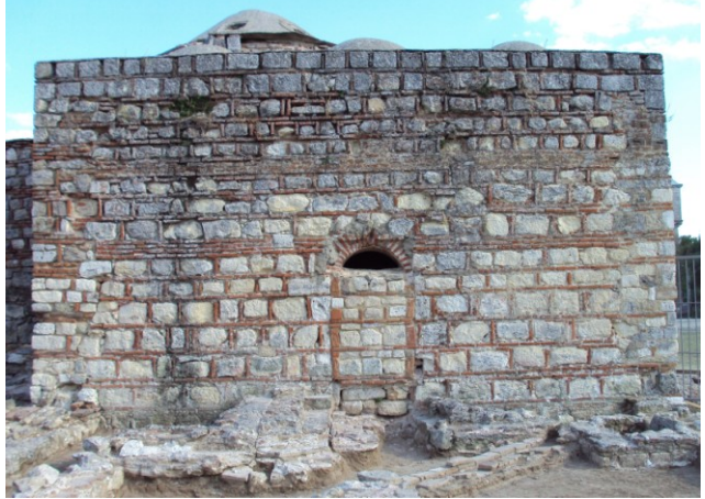
Fot. 34. Kum Kasrı Hamamı'nın kuzey cephesindeki giriş açıklığı
