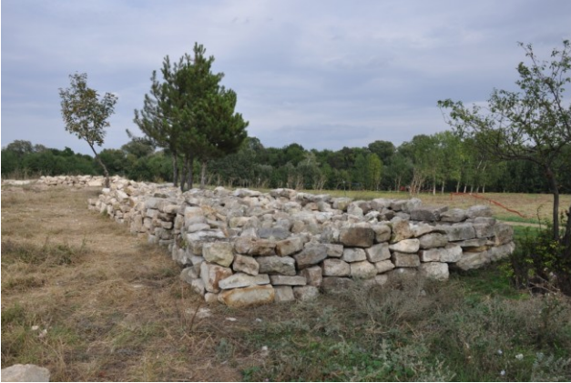
Fot. 62. Edirne Yeni Saray alanında dağınık durumda bulunan saraya ait taşların kuru duvar örülerek düzenlenmiş hali
