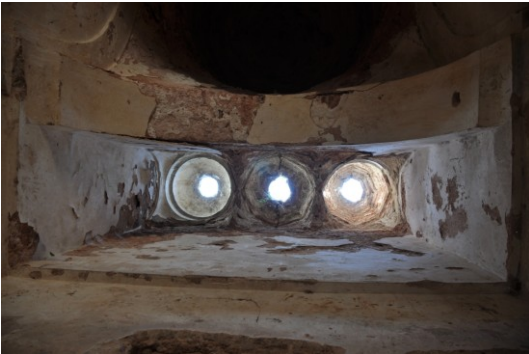
Fot. 39. Kum Kasrı Hamamı'nın ılıklik mekanının güney bölümünün örtü sistemi
