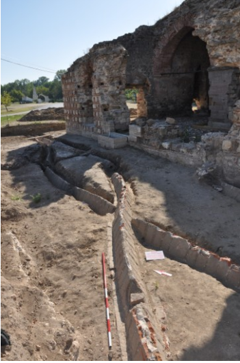
Fot. 20. Matbah-ı Amire'nin kuzey cephesinde ortaya çıkan alt yapı sistemi
