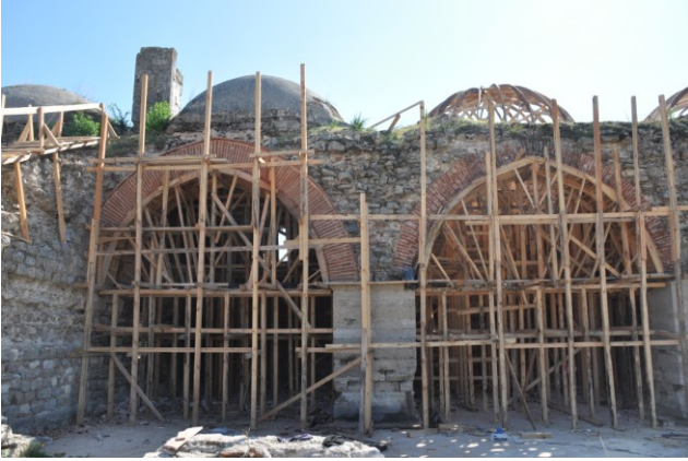
Fot. 28. Matbah-ı Amire'nin restorasyonu kapsamında yapının askıya alınması ve kubbelerin restorasyonu
