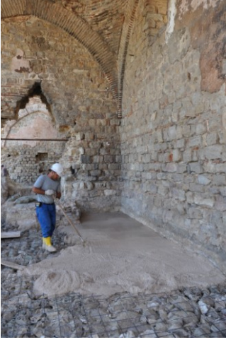
Fot. 27. Matbah-ı Amire'nin restorasyonu kapsamında iç mekan döşemesinde yapılan blokaj uygulaması
