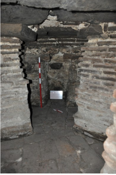
Fot. 46. Kum Kasrı Hamamı'nın cehennemlik katından bir görünüm
