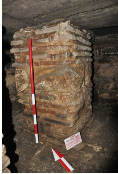
Fot. 44. Kum Kasrı Hamamı'nın cehennemliğindeki ayaklardan bir görünüm
