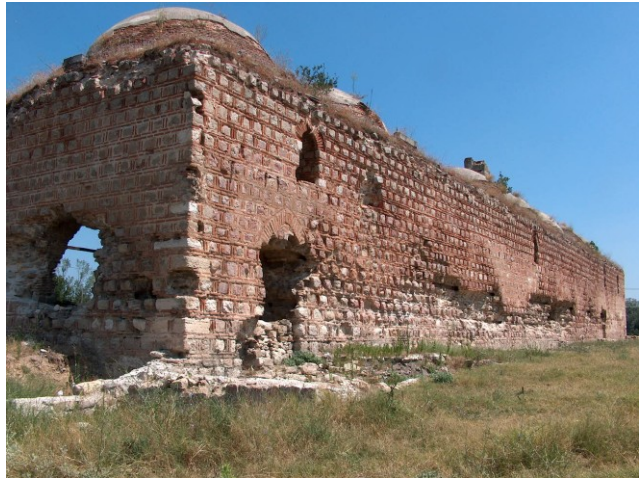
Fot. 9. Matbah-ı Amire'nin güney cephesi (kazi öncesi)
