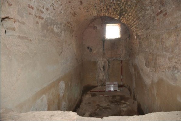
Fot. 48. Kum Kasrı Hamamı'nın su deposunun içten görünümü
