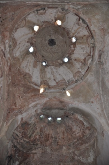
Fot. 42. Kum Kasrı Hamamı'nın sıcaklık ve halvet bölümlerinin örtü sistemi
