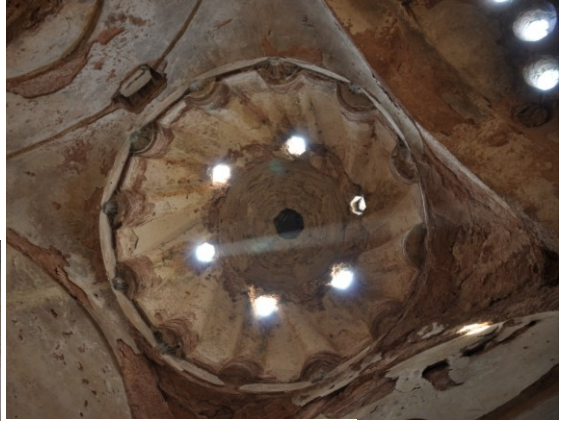
Fot. 41. Kum Kasrı Hamamı'nın sıcaklık bölümünün örtü sistemi
