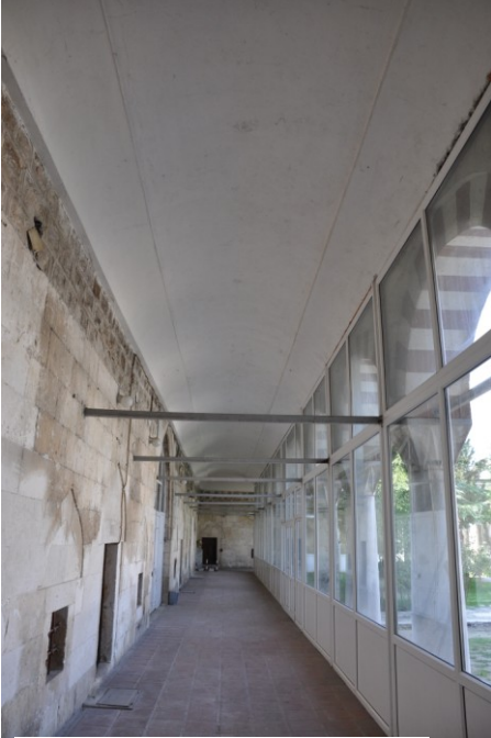
Fot. 2. Edirne Yeni Saray Kazı Evi (Peykler Medresesi)'nin revaklarından bir görünüm
