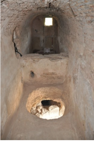
Fot. 49. Kum Kasrı Hamamı'nın su deposu ve ateşliğinin içten görünümü
