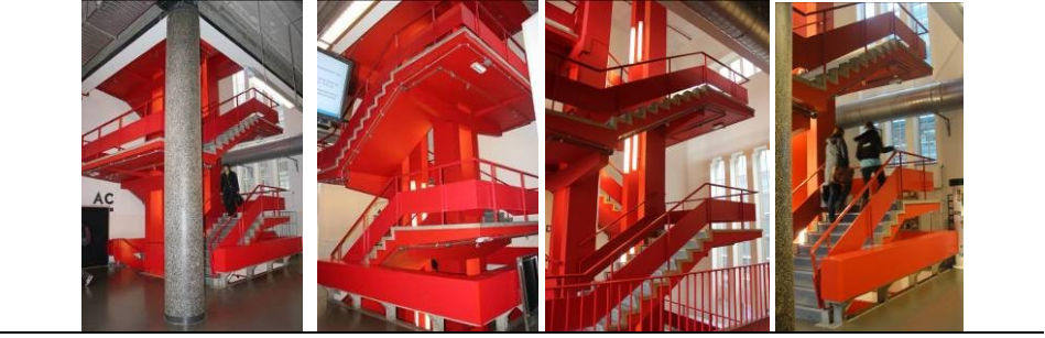
Şekil 15. Yapının elik strüktürlü, kırmızı “odak noktası” merdiveni (Al, 2012)
