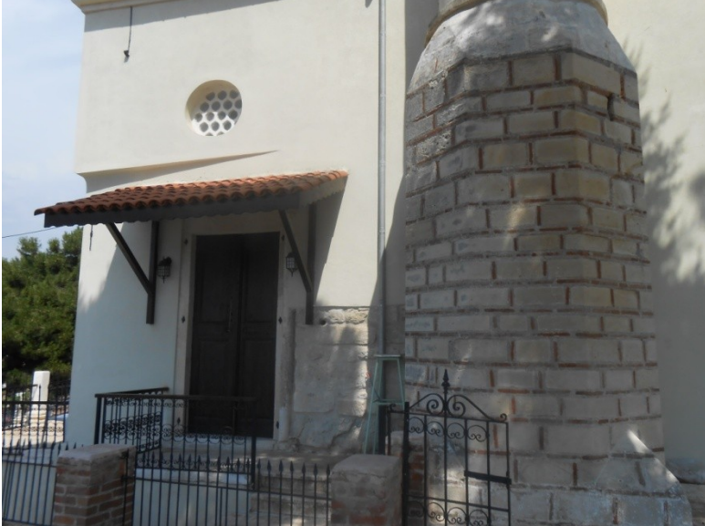
Res.6. Ulu C., batı cephedeki kapı
