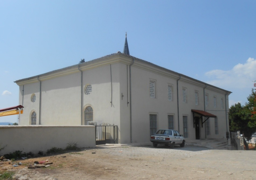
Res.4. Ulu C., güney ve doğu cephe(restorasyondan sonra)
