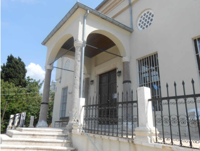
Res.11. Ulu C. kuzey cephe (restorasyondan sonra)
