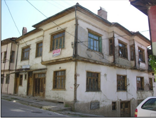
Fotoğraf 29 , Üst ve iki yan kanat sabit, ortası hareketli kanatlı pencere tipi.
