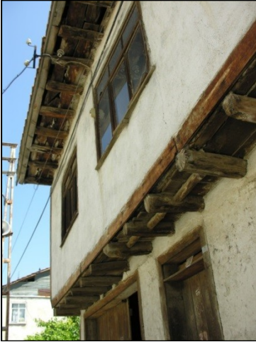
Fotoğraf 34 , Kaplamasız saçak örneği. Fotoğraf 35 , Dekoratif kaplamalı saçak örneği.
