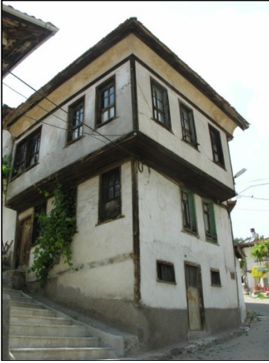
Fotoğraf 26 , Eskigediz evinde ahşap hatıllı cephe uygulaması.
