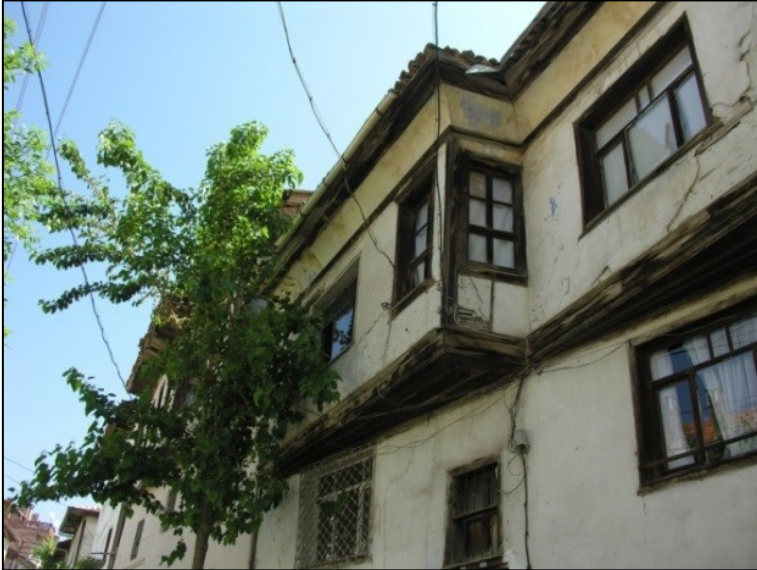
Fotoğraf 25, Ahşap hatıllı çıkmanın alttan kapatıldığı uygulama.
