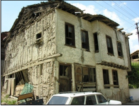
Fotoğraf 14 , Zemin katı ve üst katı bağdadi teknikli ev örneği.
