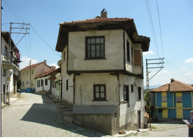
Fotoğraf 18 , Hem birinci hem de ikinci kattan girişi olan köşe ev örneği.
