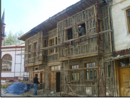
Fotoğraf 75 , Tamamı bağdadi inşa tekniği ile inşa edilmiş bir ev Eskigediz Beld. Arşv.
