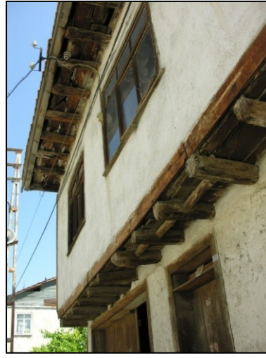
Fotoğraf 24, Ahşap hatıllı çıkma.
