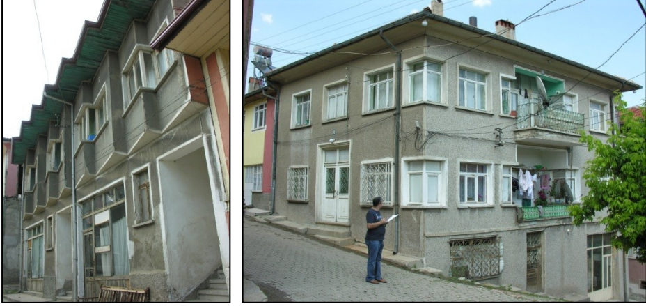
Fotoğraf 73 , Gönye çıkmalı örnek. Fotoğraf 74 , Modern balkonlu, çıkmasız bir örnek.
