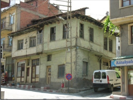
Fotoğraf 52 , Ön cephesi bir, yan cephesi iki kademeli gönye çıkmalı bir örnek.
