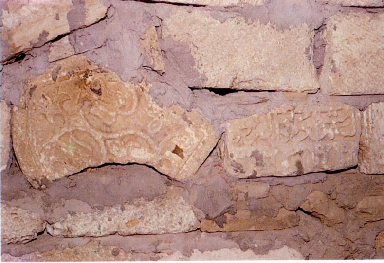
Resim 3 - Azerbaycan / Mereze, Diri Baba Türbesi. Kitabe parçalarının restorasyonda duvara yerleştirilmiş örnekleri (Fotoğraf Yaşar Çoruhlu, 1997).
