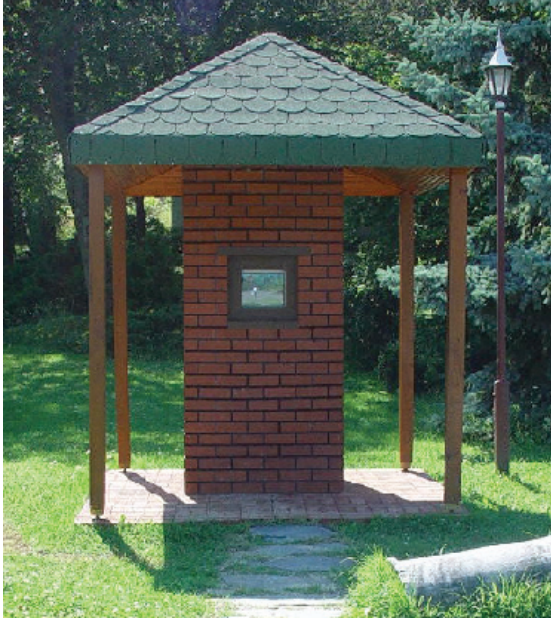
Şekil 5- Ziyaretçiler için yapılan kiosk
