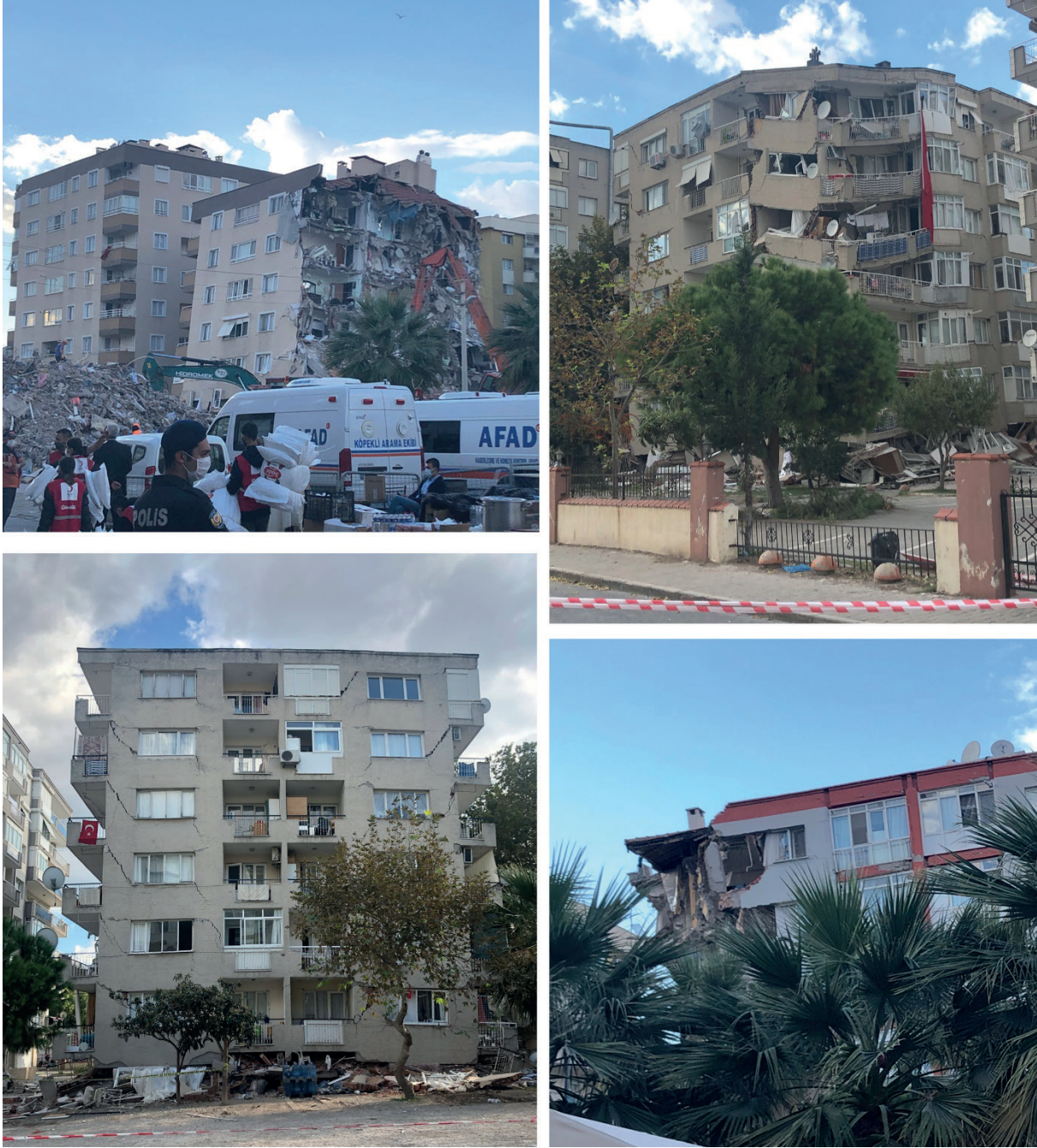
Şekil 2: Bornova Ovası'nda deprem sırasında ağır hasar alan binalardan fotoğraflar. Figure 2: Pictures of some of the buildings got damaged during Samos Earthquake.
