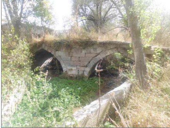
Fot.6. Nize Köyü Çift Gözlü Köprü (S. Murat TOPÇU)
