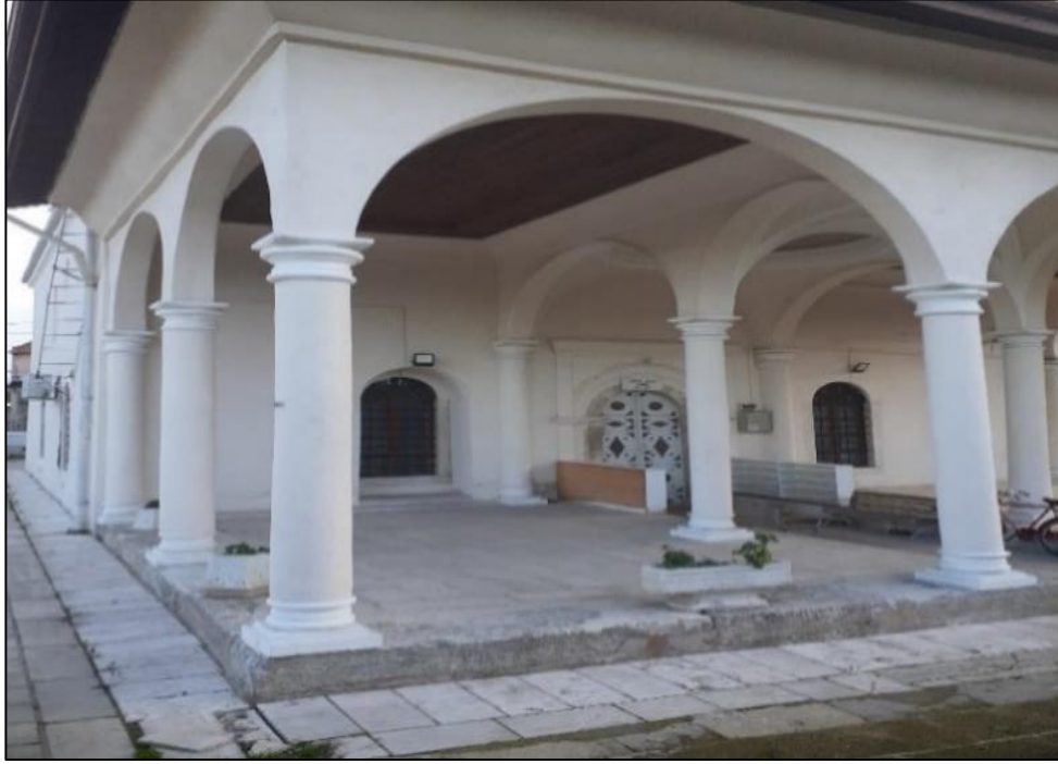
Resim-II/ Yahya Paşa Cami Son Cemaat Yeri Görünüm
