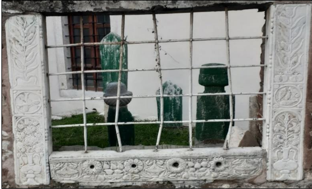
Resim-V/Yahya Paşa Cami Hazire Şebekesi Dış Duvar Pencere Söveleri
