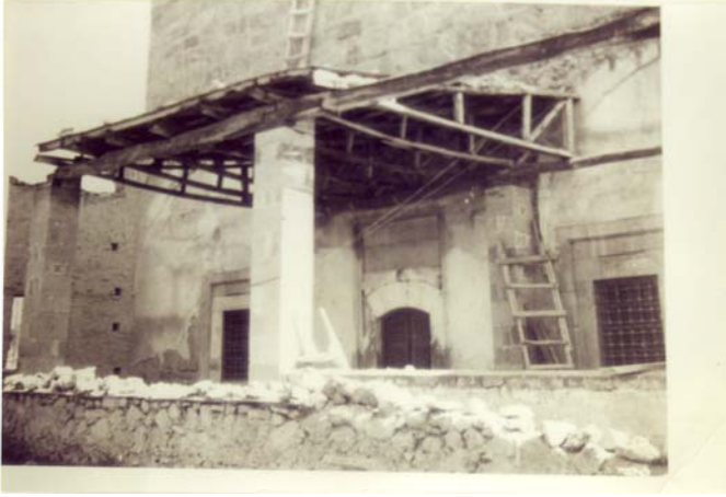
Foto 10- Kale Camii, kuzey cephe (V.G.M. Arşivi'nden).
