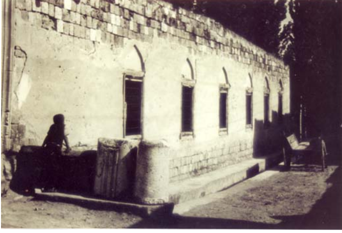
Foto 2- Alâeddin Camii, onarım öncesi batı cephe (V.G.M. Arşivi'nden).
