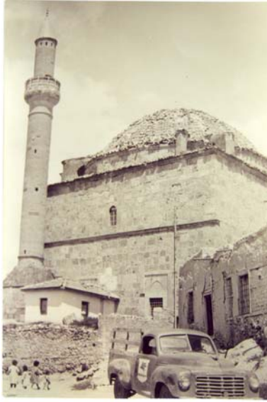
Foto 9- Kale Camii, onarım öncesi genel görünüş (V.G.M. Arşivi'nden).
