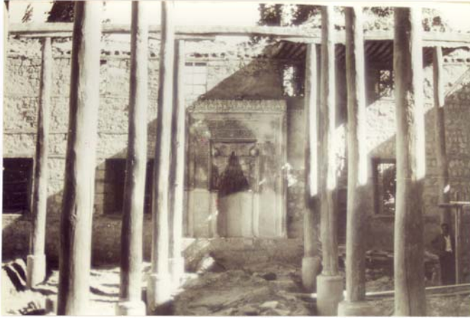
Foto 3- Alâeddin Camii, onarım öncesi harim (V.G.M. Arşivi'nden).
