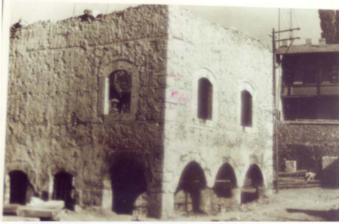
Foto 13- Dabakhane Camii, onarımdan önceki durumu (V.G.M. Arşivi'nden).
