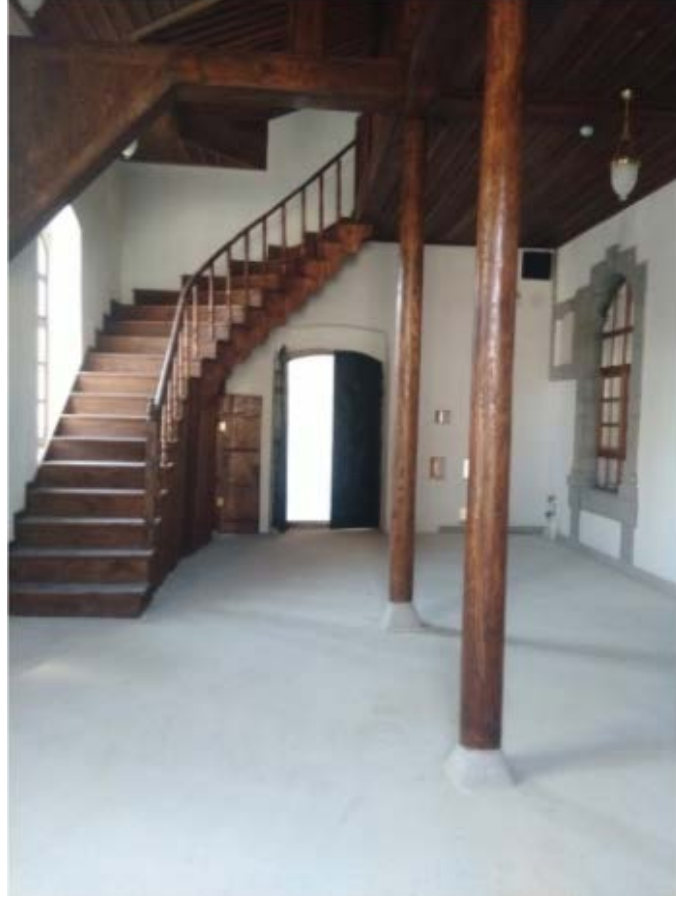
Resim 8: Son cemaat mekanı kadınlar mahfiline çıkan ahşap merdiven (V.Kütahya B.M. arşivi).
