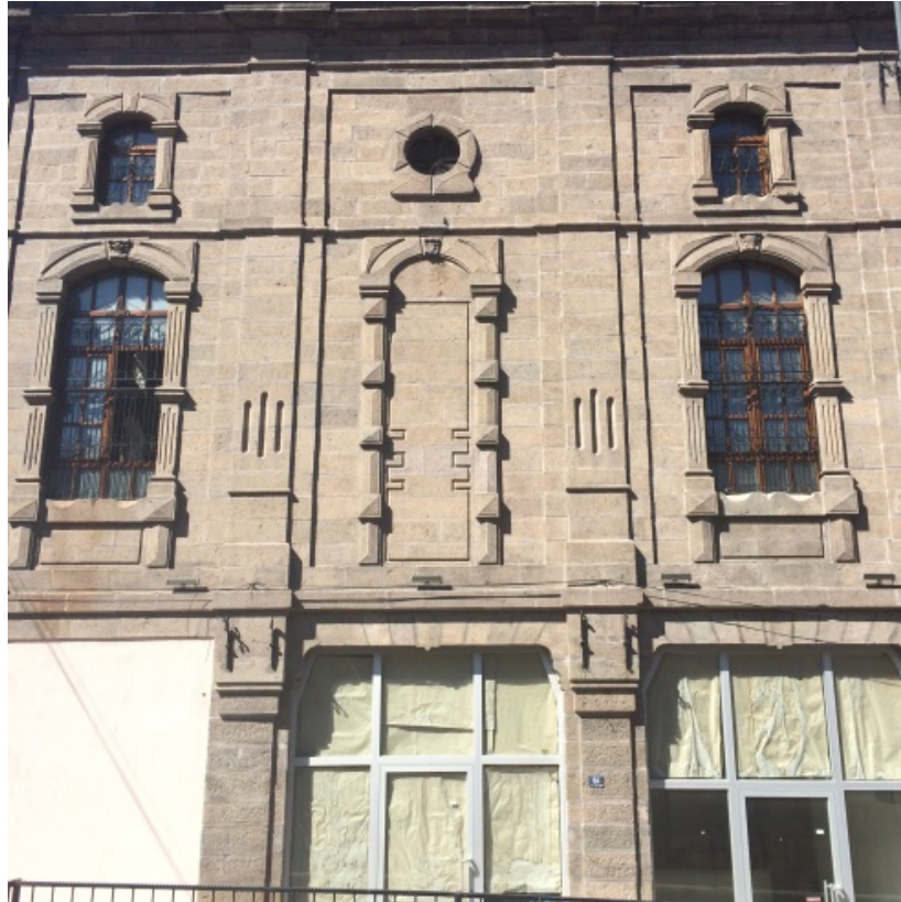
Resim 21: Cami bölümü güney cephe mihrap nişi detayı; moloz örgü üzeri kesme taş kaplama (Yazarın arşivi, 2013).
