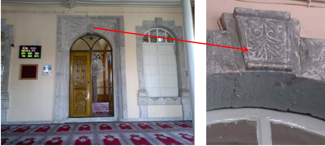
Resim 10: Son cemaat mekanı güney duvarı - Harim kapı detayı (Yazarın arşivi, 2013).
