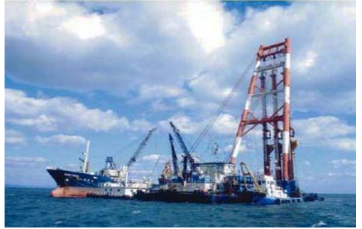
Şekil 14. Kum Kompaksiyon Kazıklarının Denizde Yerleştirilmesi. (Kitazume, 2007)
