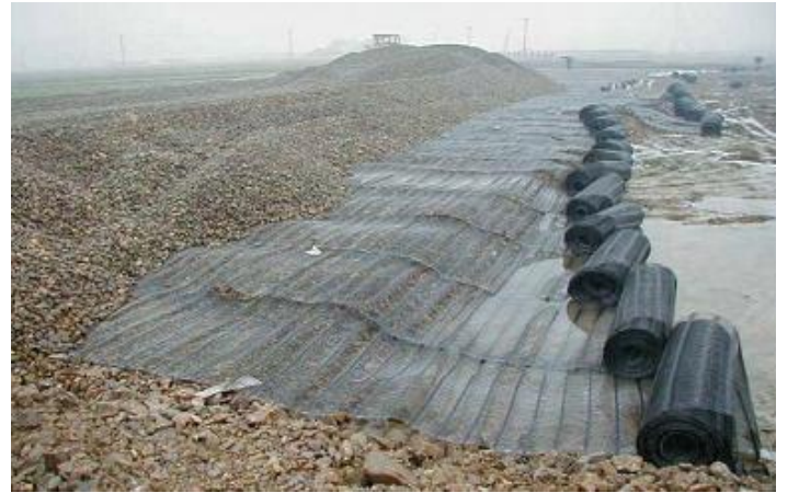
Şekil 18. Platformda Uygulanan Geosentetik. (H.L.Liu, 2009)
