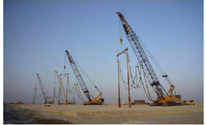
Şekil 2. Dubai Palm projesinde kullanılan titreşimli sondalar. (Wehr, 2007)
