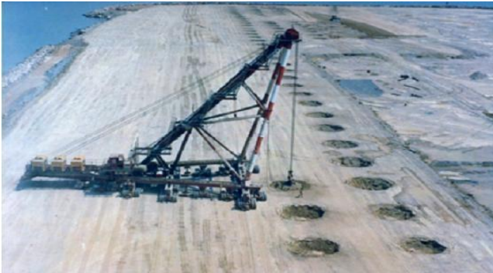
Şekil 1. Nice Havaalanı yapımında kullanılan dinamik kompaksiyon. (Jian Chu, 2009)
