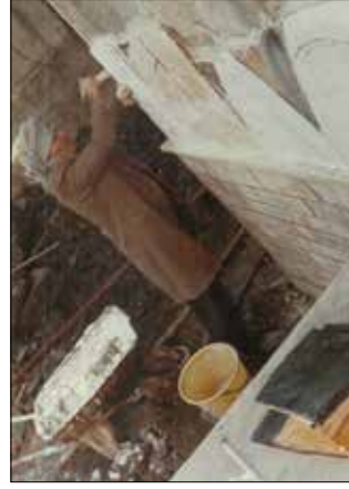
Fotoğraf 7: Sait Usta seramik duvar panosunun montajında (Sühendan Uluğ Arşivi, 1984). / Master Sait at ceramic wall panel's assembly (Sühendan Uluğ Archive, 1984).
