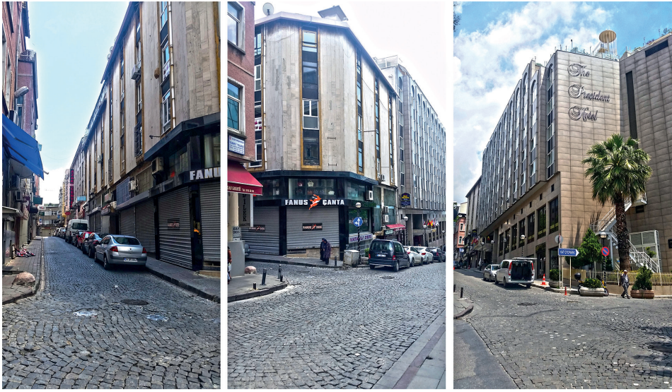
Şekil 20 Günümüzde yapı adasında mevcut olan betonarme yapılar.
