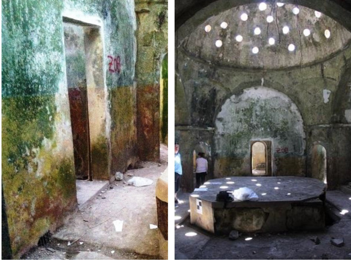
Şekil 10: Tarihi Hamam'ın sıcaklık bölümünden ılıklık bölümüne geçiş kapısı ve sıcaklık bölümü-göbek taşı
