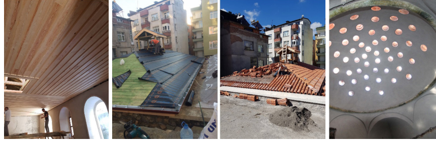
Şekil 19: Yerinde bırakılmayacak ölçüde bozulmuş yapı elemanlarının aslına uygun olarak yapılması
