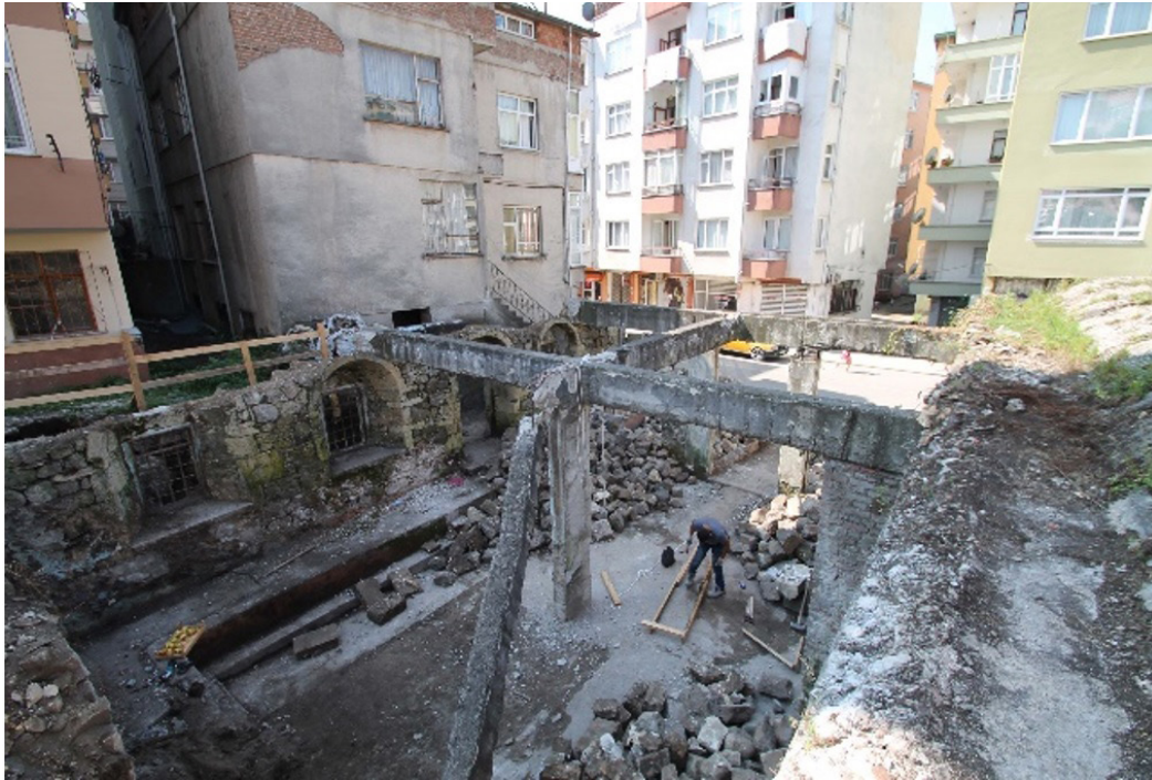
Şekil 14: Yapıya sonradan eklenmiş olan niteliksiz muhdes eklerin kaldırılması
