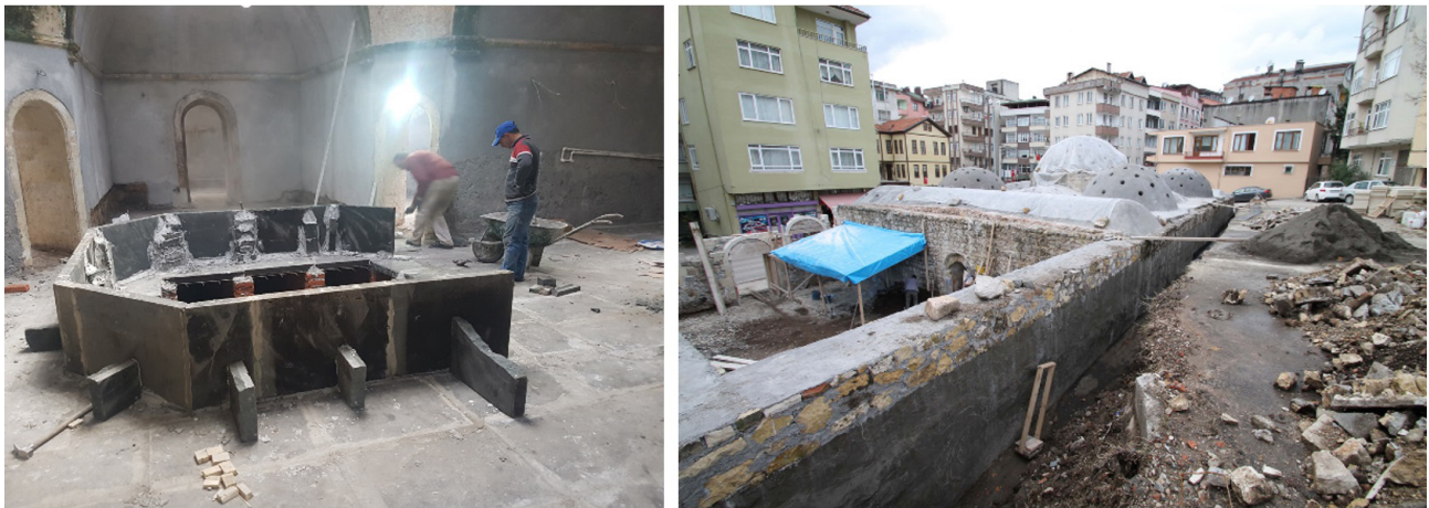
Şekil 17: Bütünleme, eksik parçaların ve elemanların aslına uygun olarak tamamlanması
