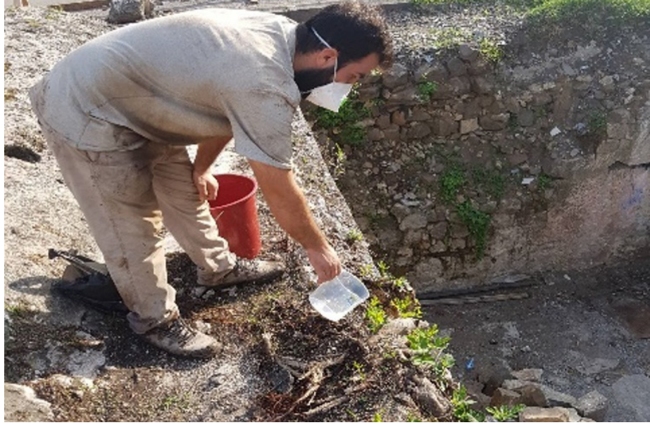
Şekil 15: Özgün yapı elemanlarının biyolojik hasarlarının uygun yöntemlerle temizlenmesi ve sıhhileştirilmesi
