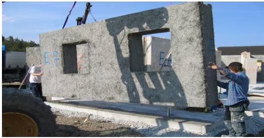
Şekil 12. Monoblok bina inşası
