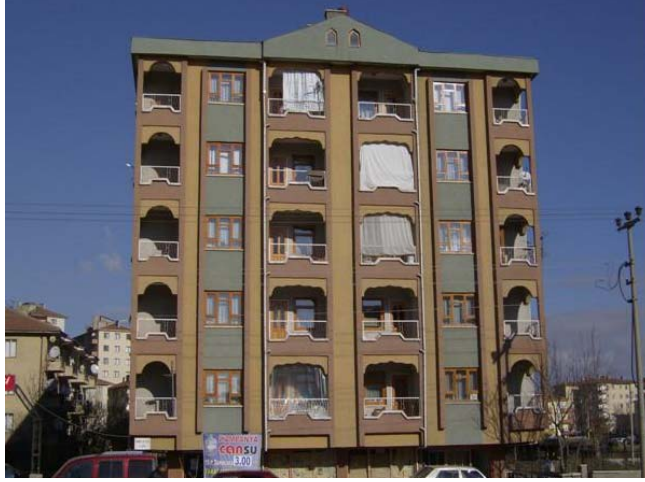
Şekil 3. Bina cephelerinde oluşan görsel kirlilik
