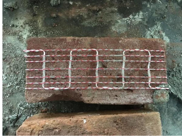
Şekil 1. Çalışmada kullanılan Murfor® yatay derz donatısının tatbiki.
