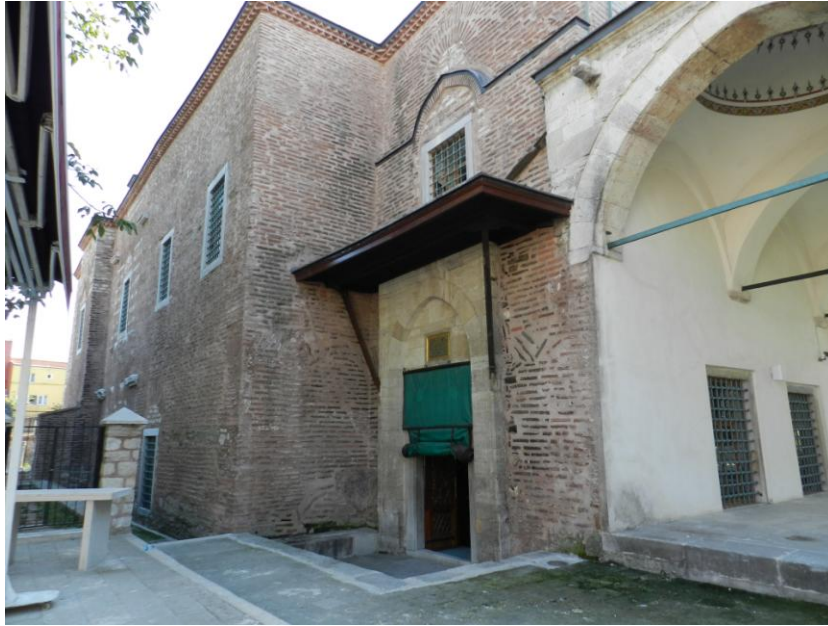
Fotoğraf: Yan Cephedeki Giriş Kapısı
