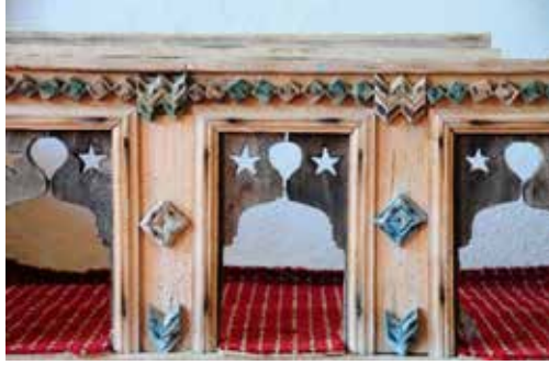
Resim 10. Uzundere (Osmaniye) köyü Camii Mihrap Sekisi Korkuluğu (Detay)
