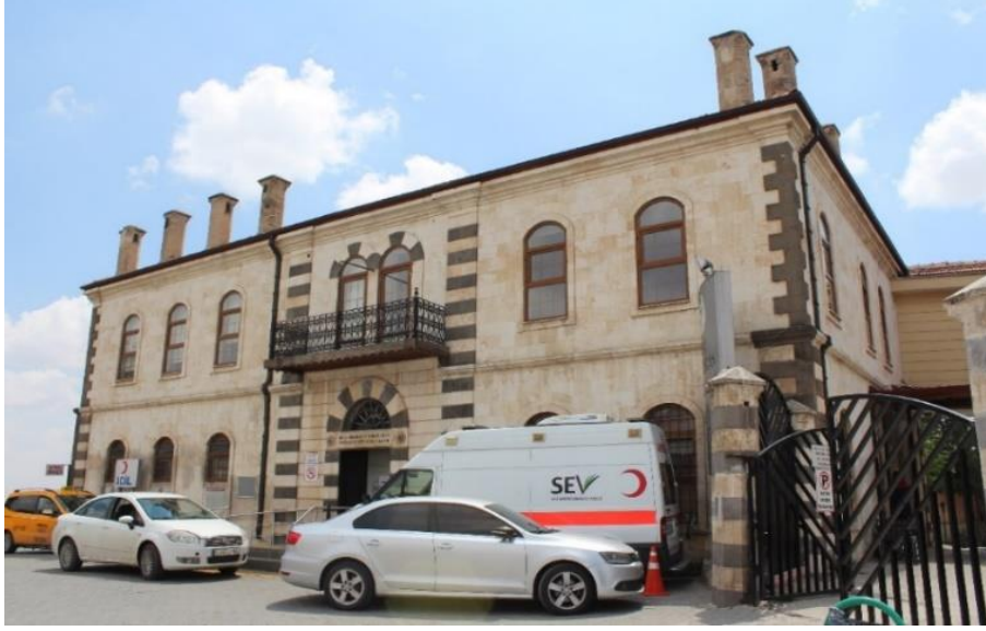
Şekil 13: Marston Binasının Kuzey Cephesi
