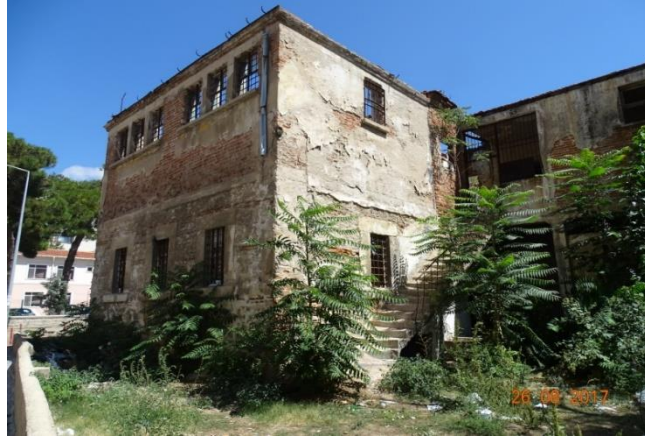
Resim 34: Batı cephesi, köşe
