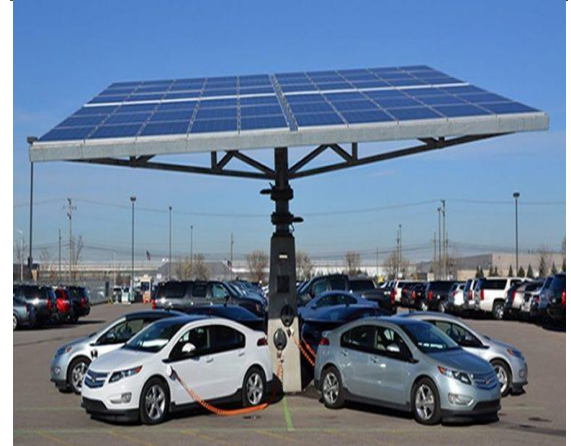
Şekil 7 Otopark güneş panelleri ile elektrik şarj istasyonları
