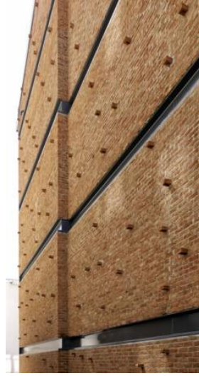
Şekil 18. Noxx Apartmanı, sağır yan cephe (Gür, 2015)
